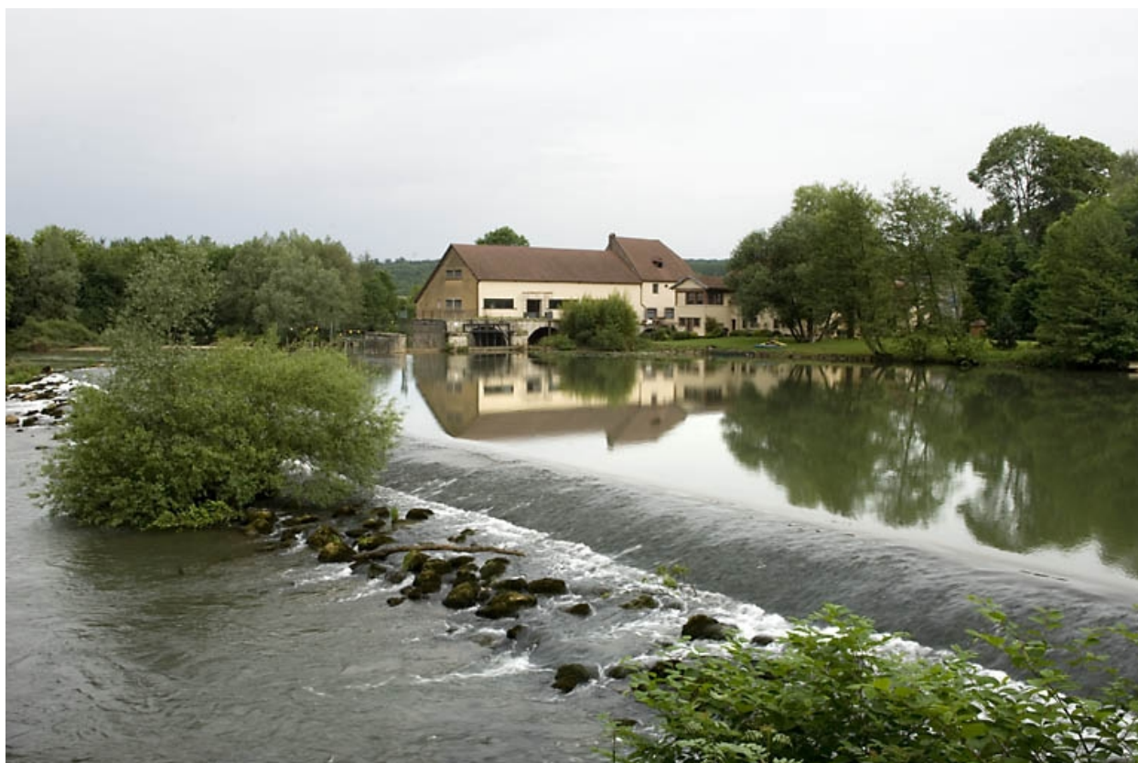
Vue d'ensemble depuis la rive gauche.
