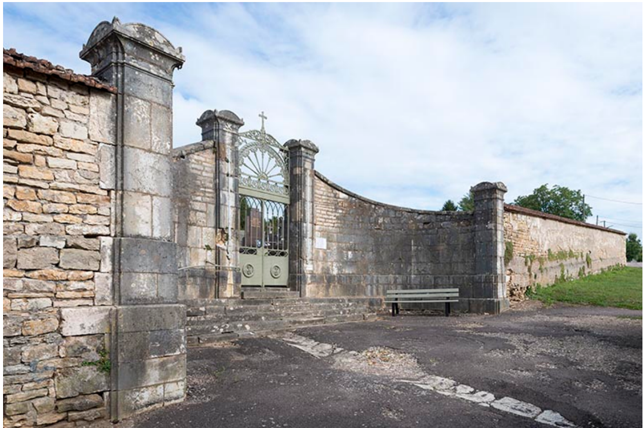
Entrée du cimetière, vue de trois-quarts.
