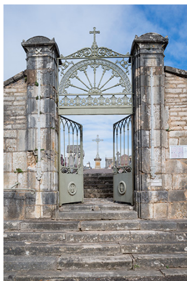
Le portail d'entrée. Phot. Jérôme Mongreville IVR43_20177000992NUC4A
