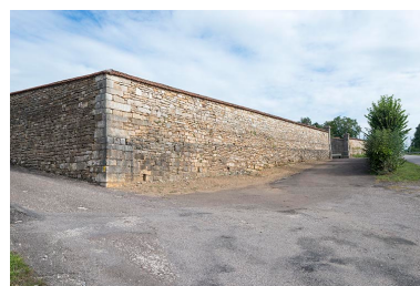
Le mur d'enclos du cimetière. Phot. Jérôme Mongreville IVR43_20177000993NUC4A
