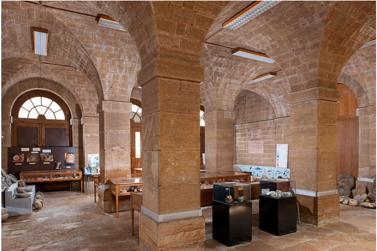
Intérieur : vue générale en direction des baies donnant sur la rue des Halles.
