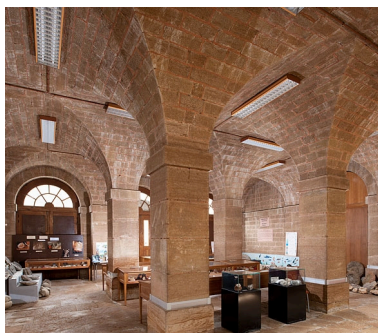
Intérieur : vue générale en direction des baies donnant sur la rue des Halles. Phot. Jérôme Mongreville IVR43_20102500577NUC4A
