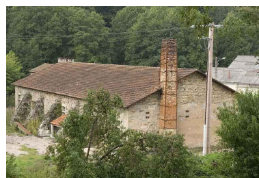
Halle vue de trois quarts arrière. Phot. Jérôme Mongreville IVR43_20067000693NUCA
