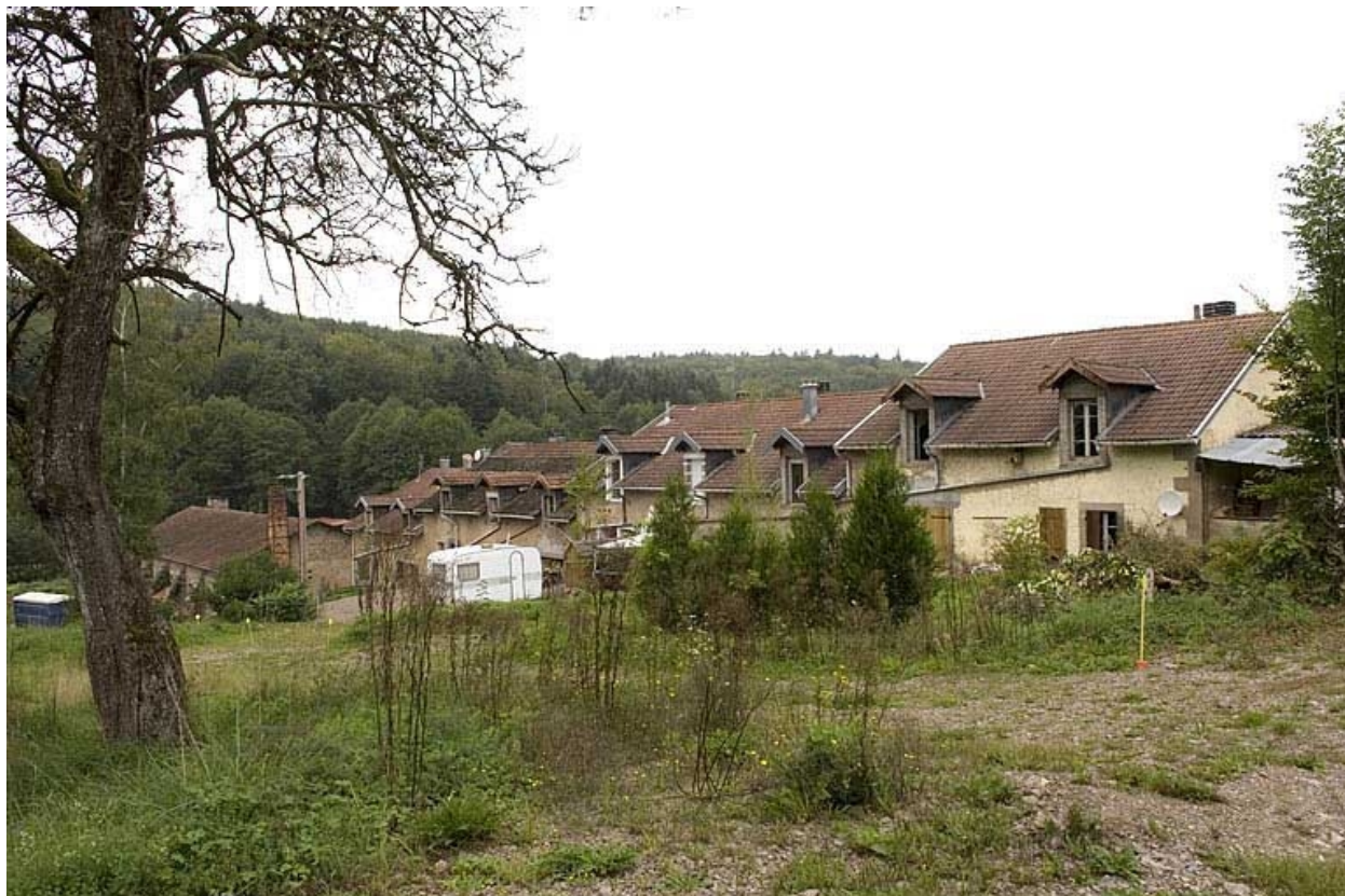
Halle et logements d'ouvriers depuis le sud-est.
