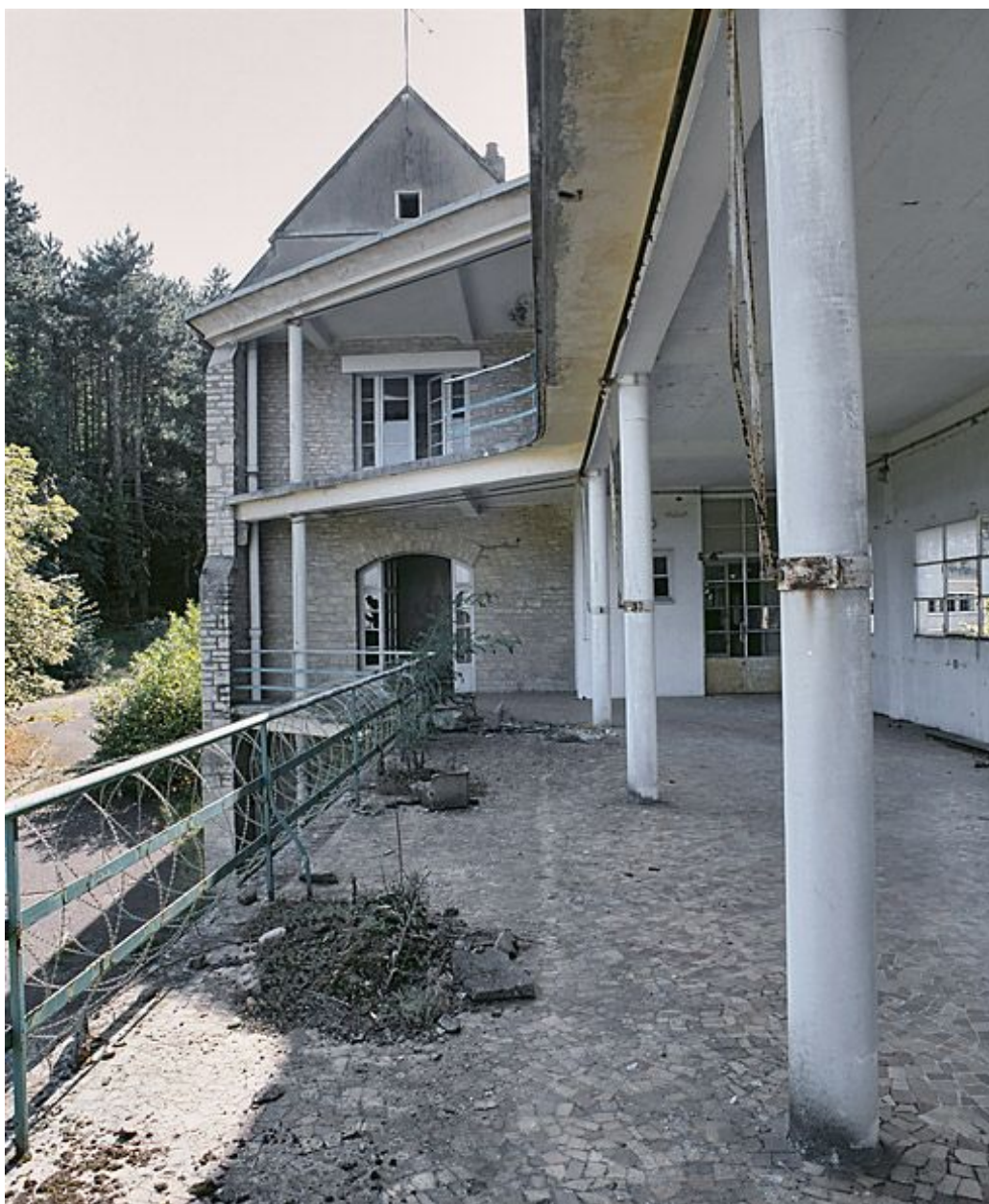
Galerie de cure est, façade sud-est.
