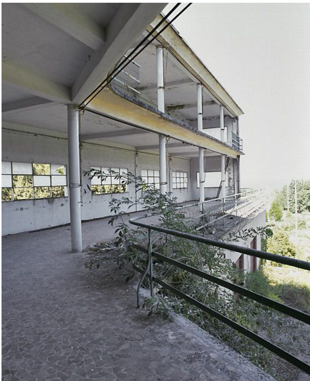
Galerie de cure est, façade sud-est.
