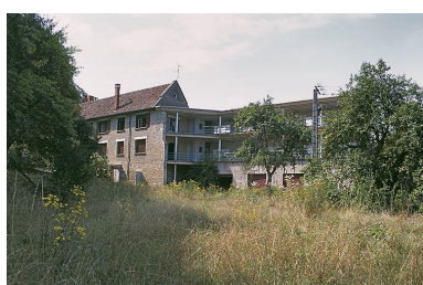
Galerie de cure est, façade sud-est. Phot. Michel Rosso IVR26_20012101213ZA
