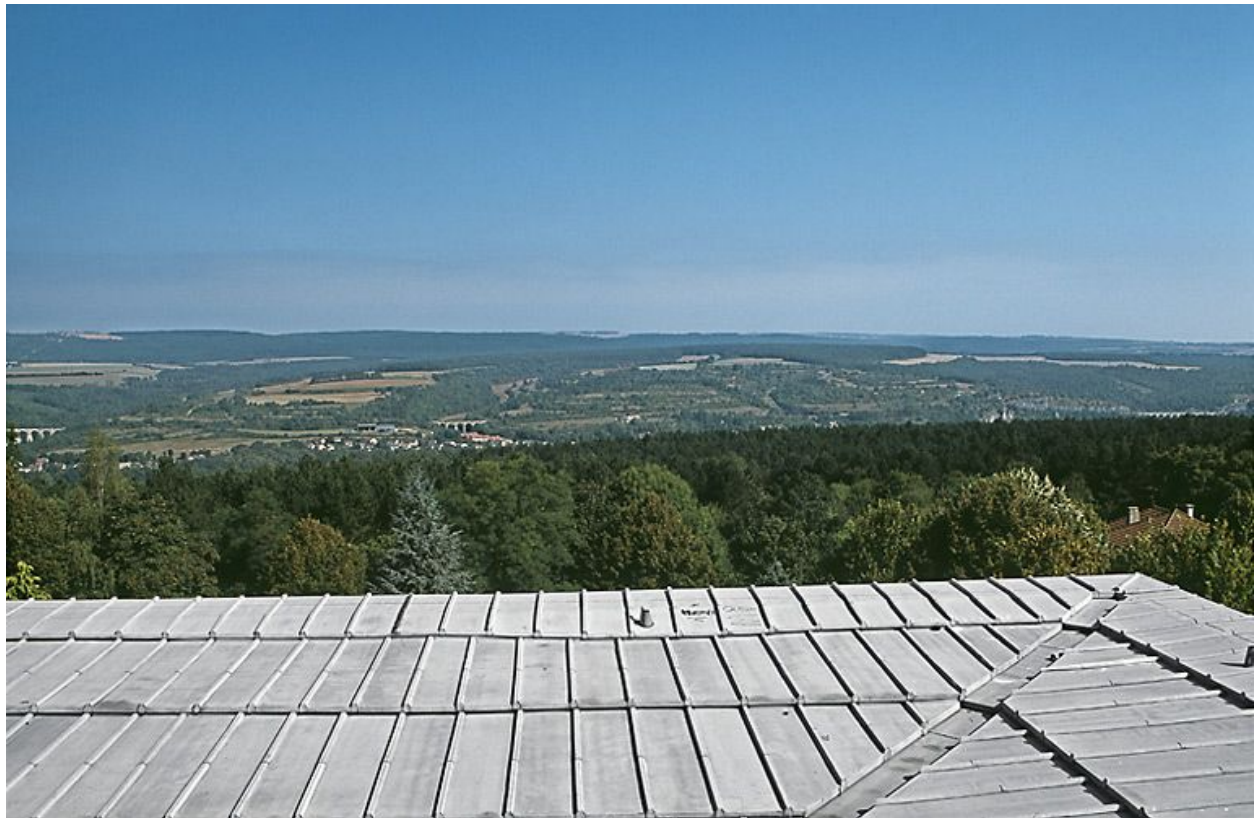
Toiture de l'aile ouest et site.
