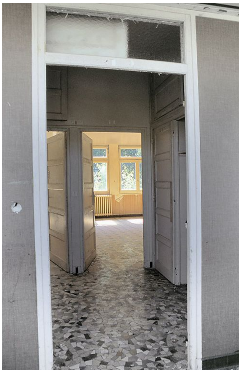
Aile ouest, accès aux chambres.
