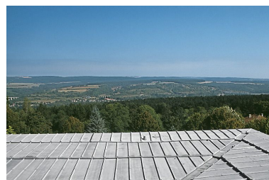
Toiture de l'aile ouest et site. Phot. Michel Rosso IVR26_20012101244ZA
