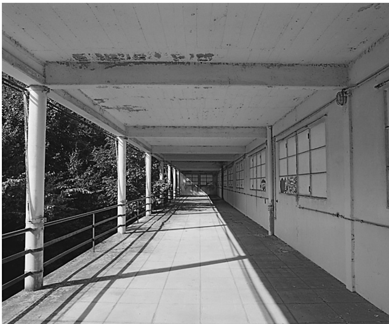
Galerie de cure ouest, façade sud-est.
