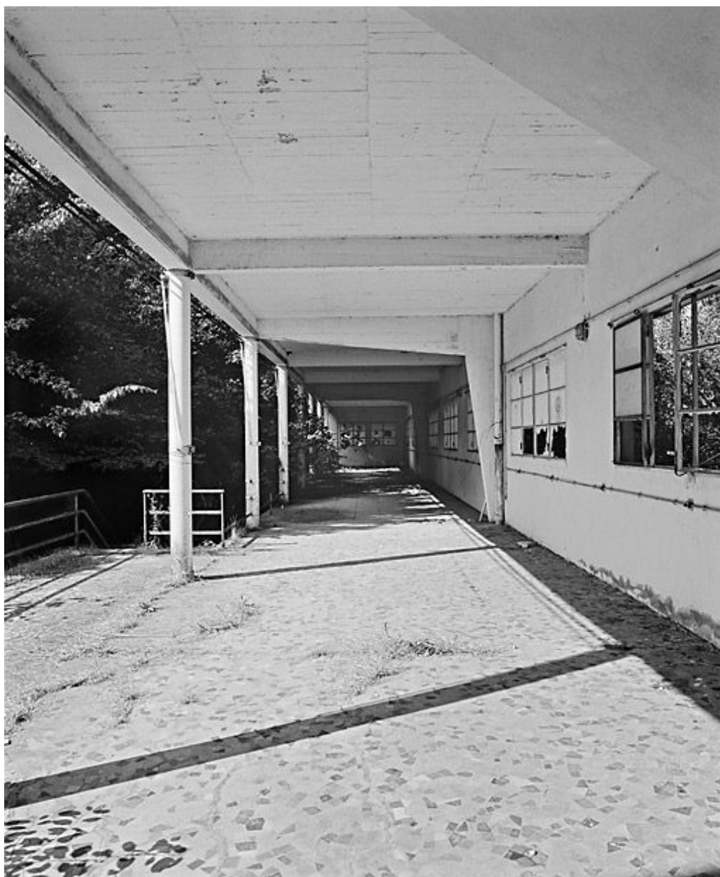
Galerie de cure ouest, façade sud-est.
