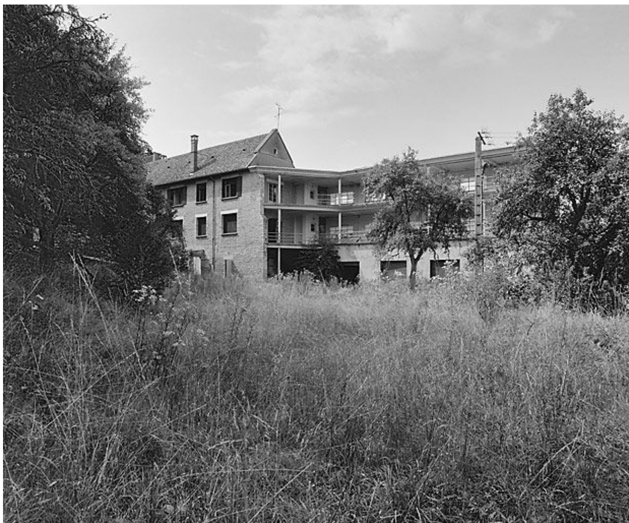
Galerie de cure est, façade sud-est.
