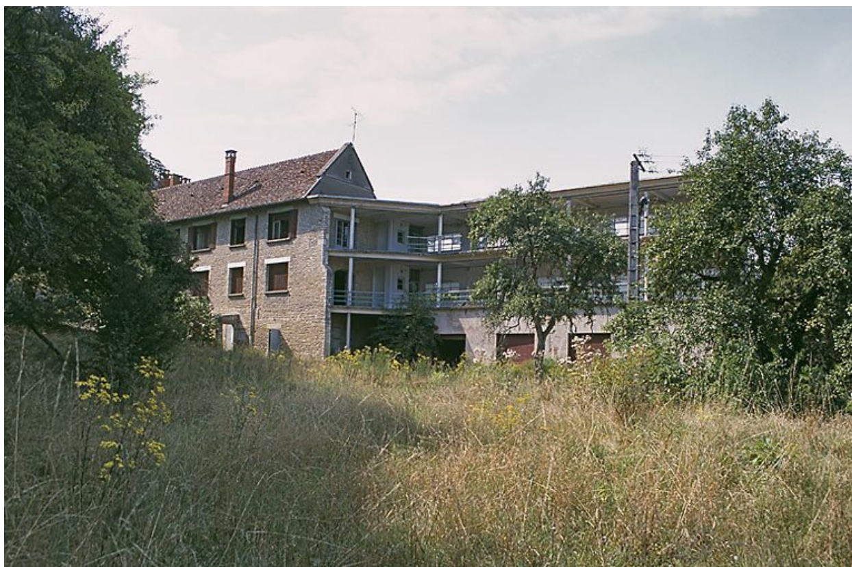
Galerie de cure est, façade sud-est.
