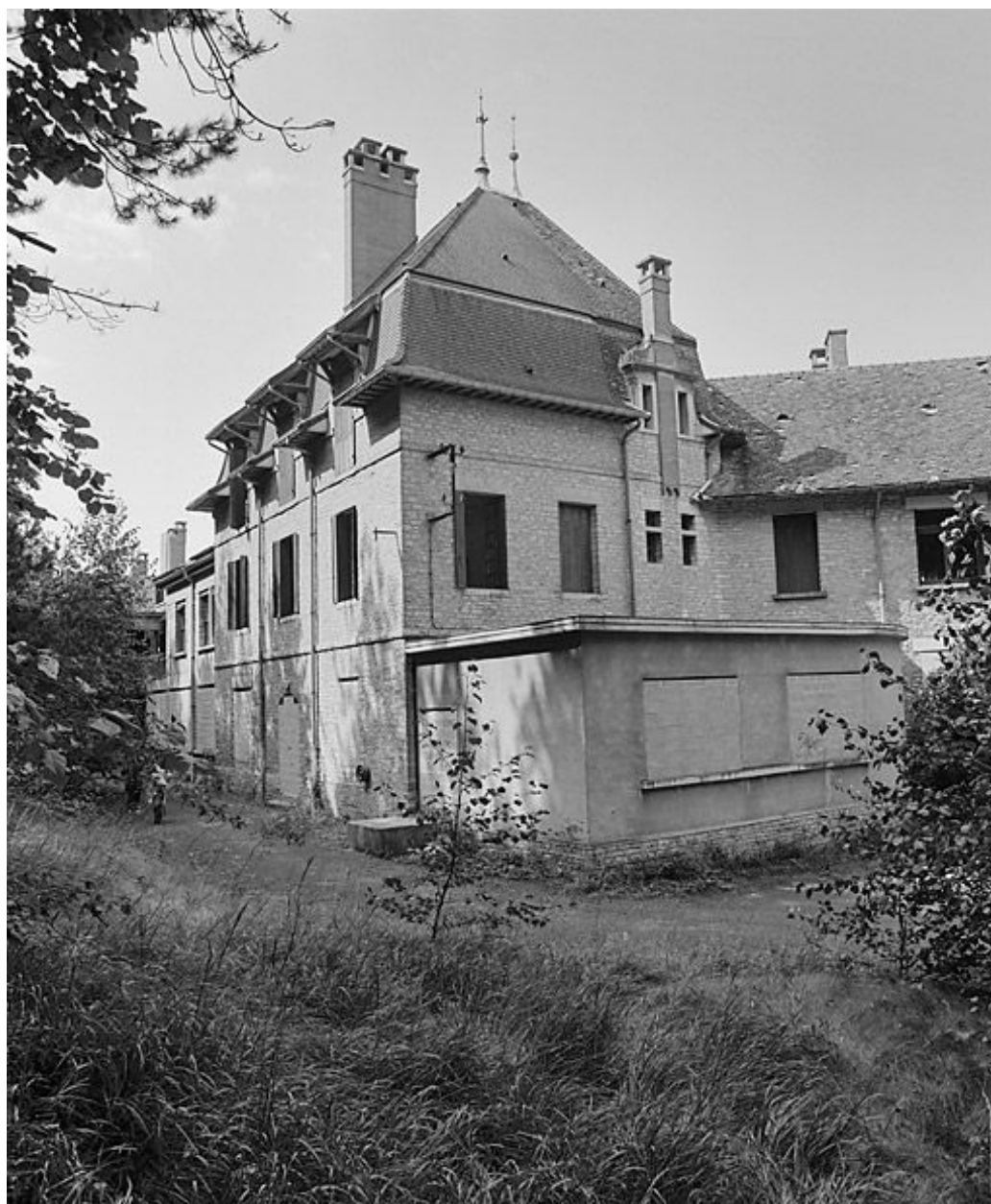
Pavillon du corps de bâtiment central.
