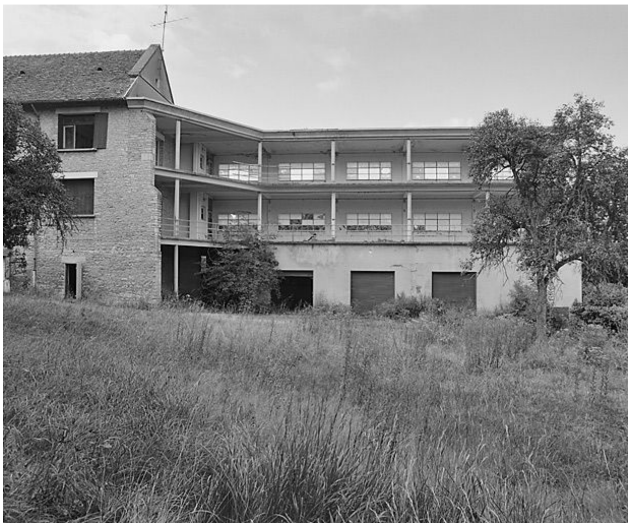
Galerie de cure est, façade sud-est.
