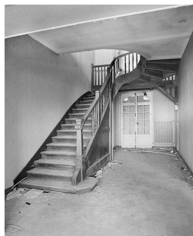
Pavillon est du bâtiment central : escalier. Phot. Michel Rosso IVR26_20012101240X
