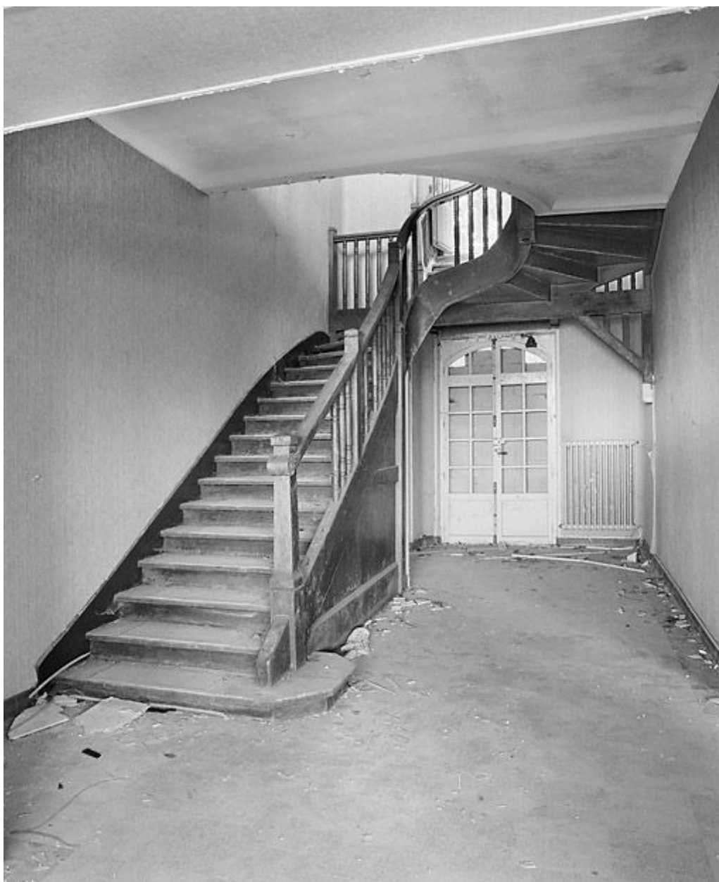
Pavillon est du bâtiment central : escalier.
