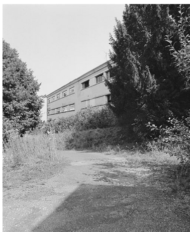
Galerie de cure, élévation nord-ouest. Phot. Michel Rosso IVR26_20012101193X
