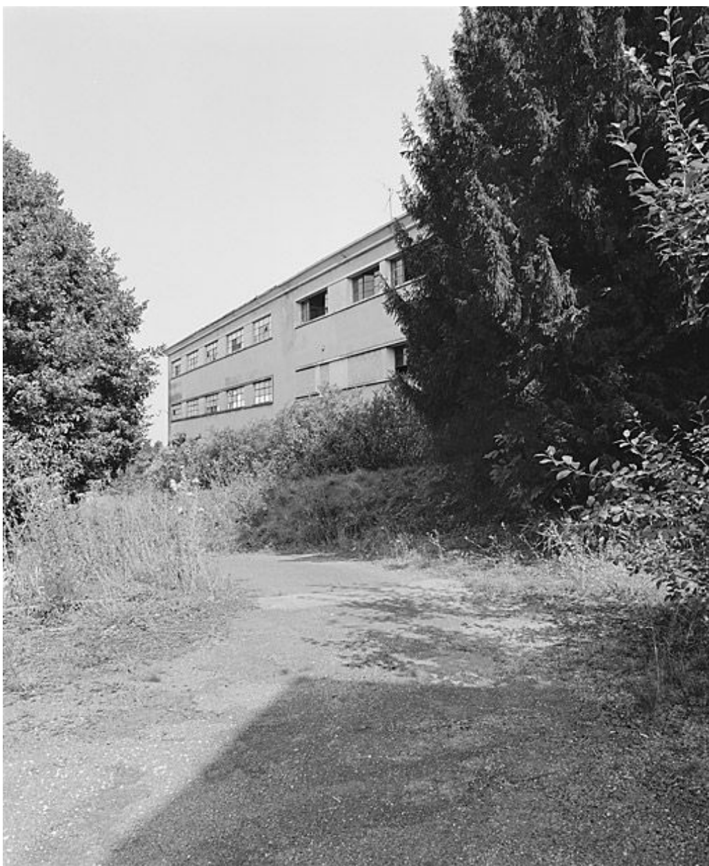
Galerie de cure, élévation nord-ouest.
