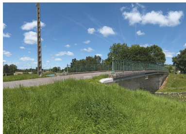
Le pont routier vu d'aval.
