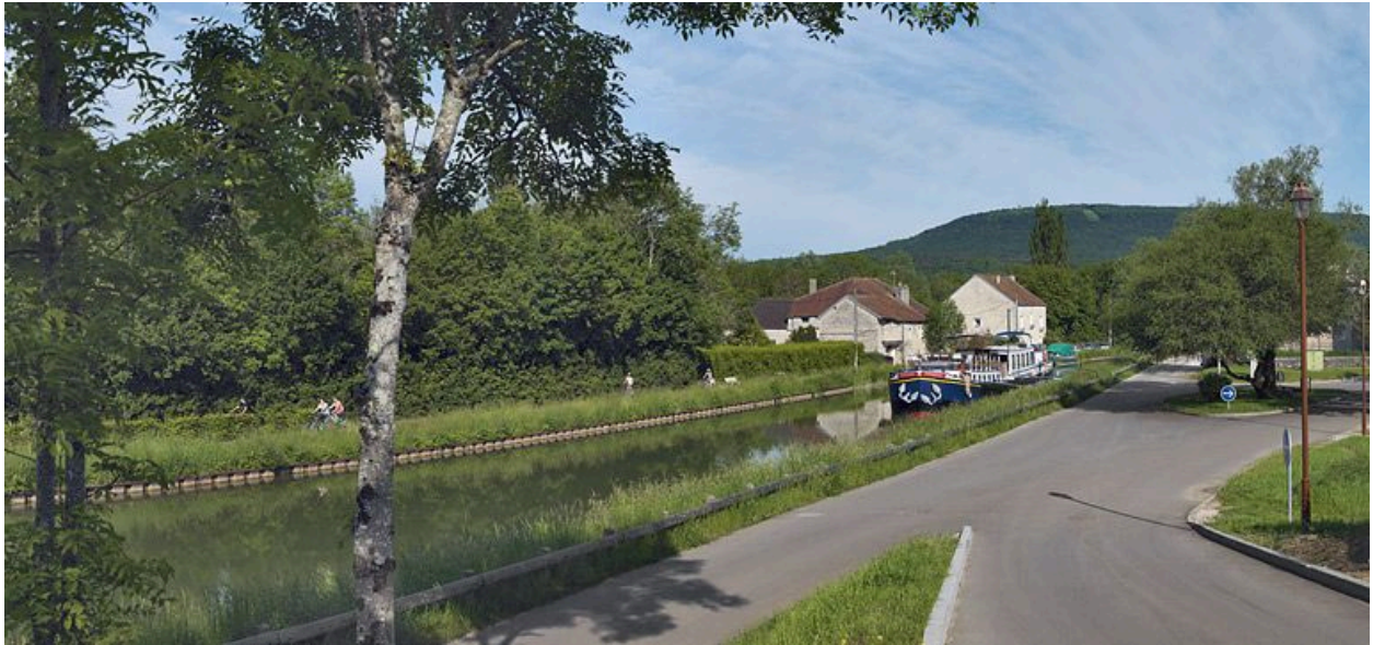
La traversée de Fleurey-sur-Ouche par le canal : vue sur Notre-Dame-de-l'Etang. Le long de la rive gauche du canal : l'ancien moulin des Roches.
