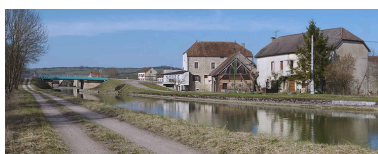
Arrivée en amont du pont à Clamerey : fermes sur la rive droite. Phot. Thierry Kuntz IVR26_20122102707NUC4A
