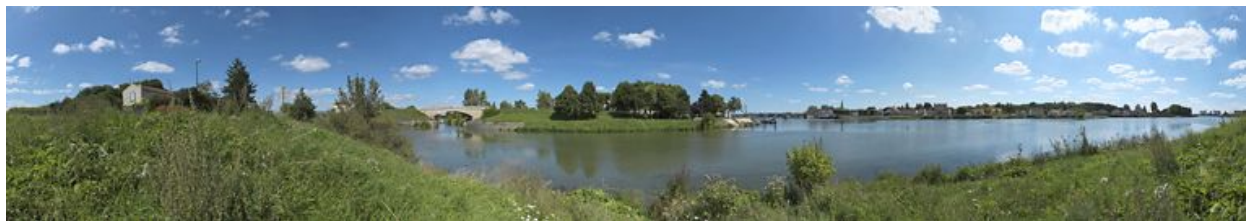
Vue d'ensemble du débouché du canal dans la Saône.
