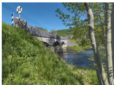
Le pont ancien en pierre sur l'Ouche à Saint-Victor-sur-Ouche.
