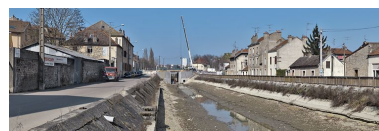
La traversée du canal à Dijon : habitations et locaux professionnels en bordure du canal. Le bief est vide pour permettre la réfection du pont sur l'écluse 55.
