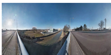
Le centre d'aiguillage SNCF depuis le pont du boulevard Maillard, bief 56 du versant Saône, à Dijon. Les infrastructures ferroviaires se sont installées de chaque côté du canal. Elles cèdent la place à des opérations immobilières. A l'emplacement des grandes minoteries dijonnaises (derrière le petit bassin de port) se construit un éco-quartier. A l'arrière-plan, le pont sur l'écluse 55 du versant Saône, qui ferme le port de Dijon, a été transformé pour accueillir le tram, c'est pour cela que le bief est vide. Phot. Thierry Kuntz IVR26_20112102915NUC4AQ
