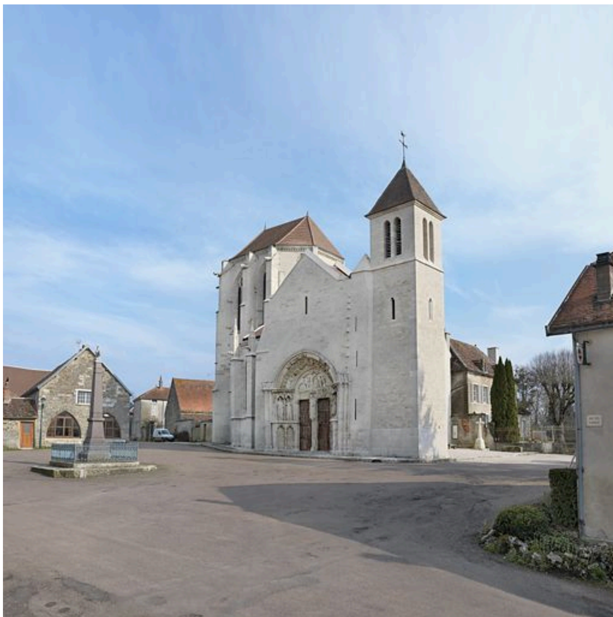
Façade de l'église paroissiale de Saint-Thibault, avec à gauche, le monument aux morts.
