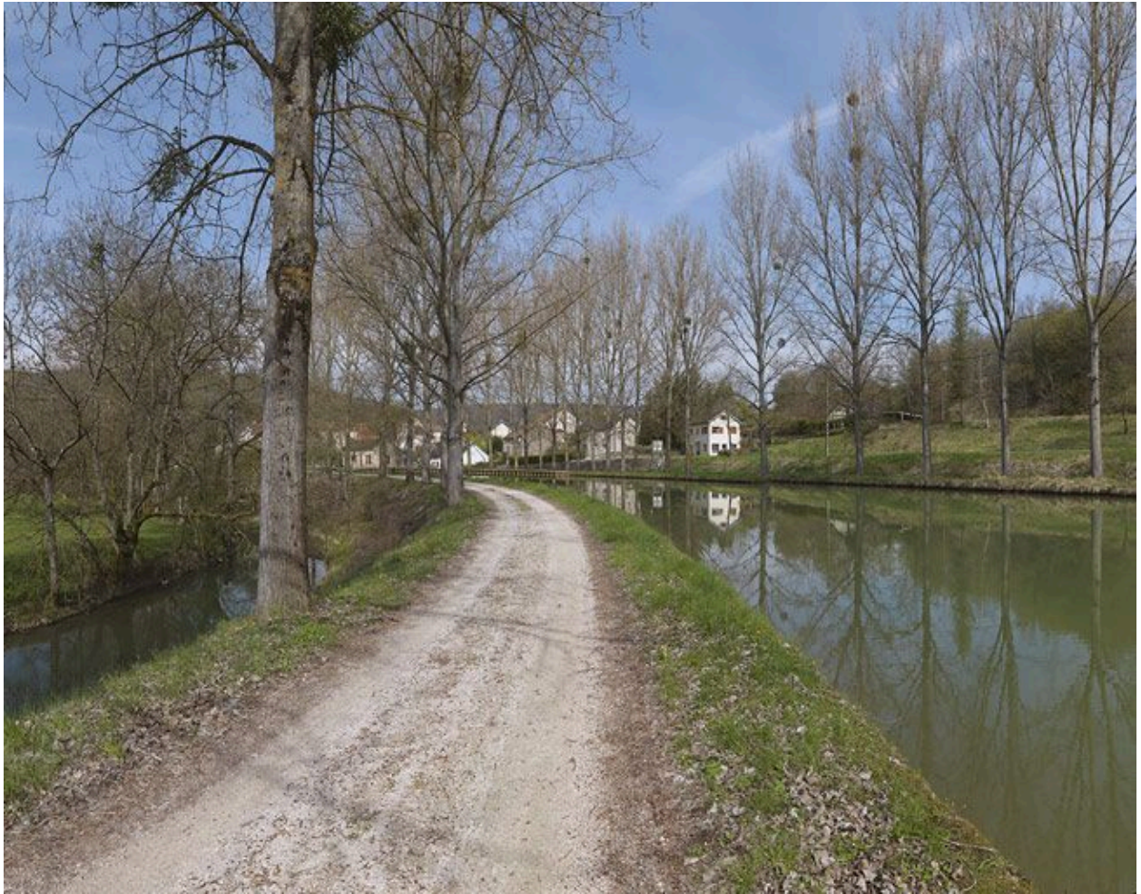
Passage du canal dans la vallée de l'Ouche : l'Ouche, le chemin de halage, au fond : le site d'écluse 25 et le canal avec un alignement d'arbres de chaque côté.
