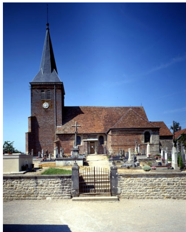
Façade latérale droite. Phot. Yves Sancey IVR43_19903901130VA
