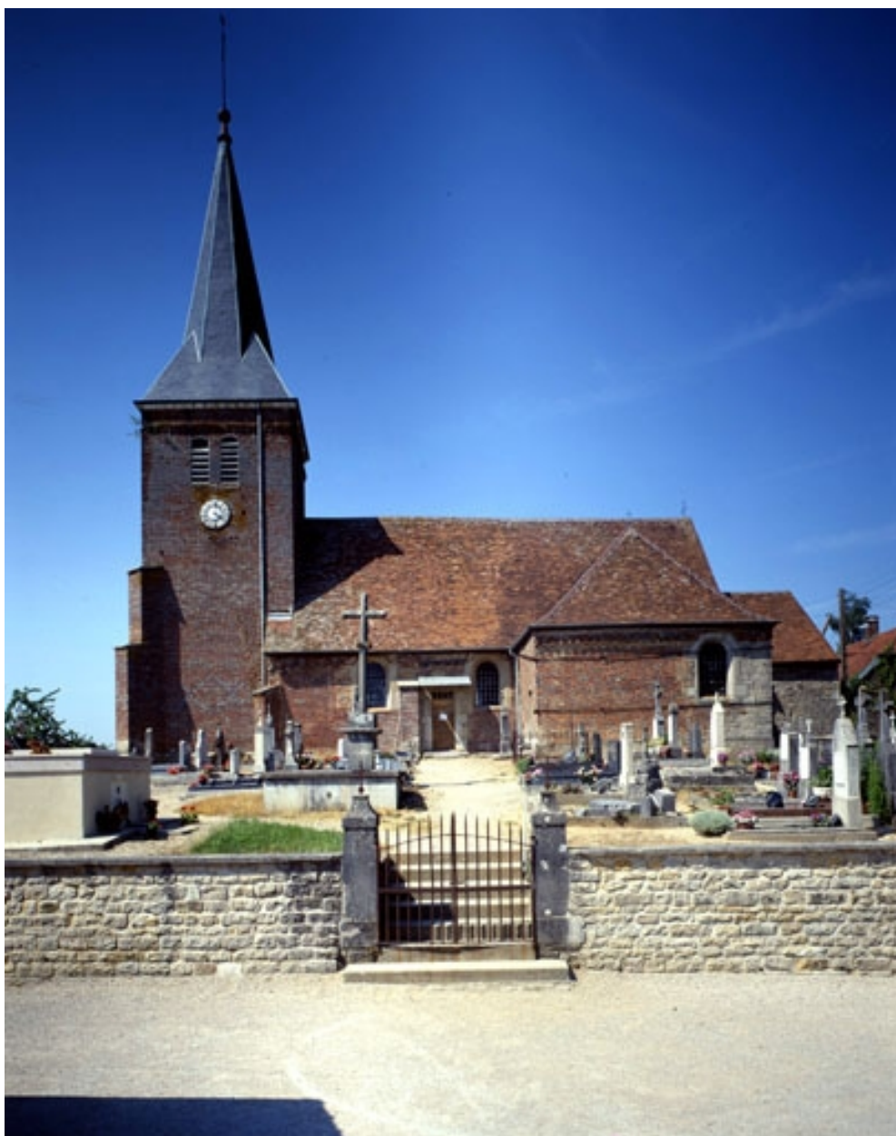
Façade latérale droite.
