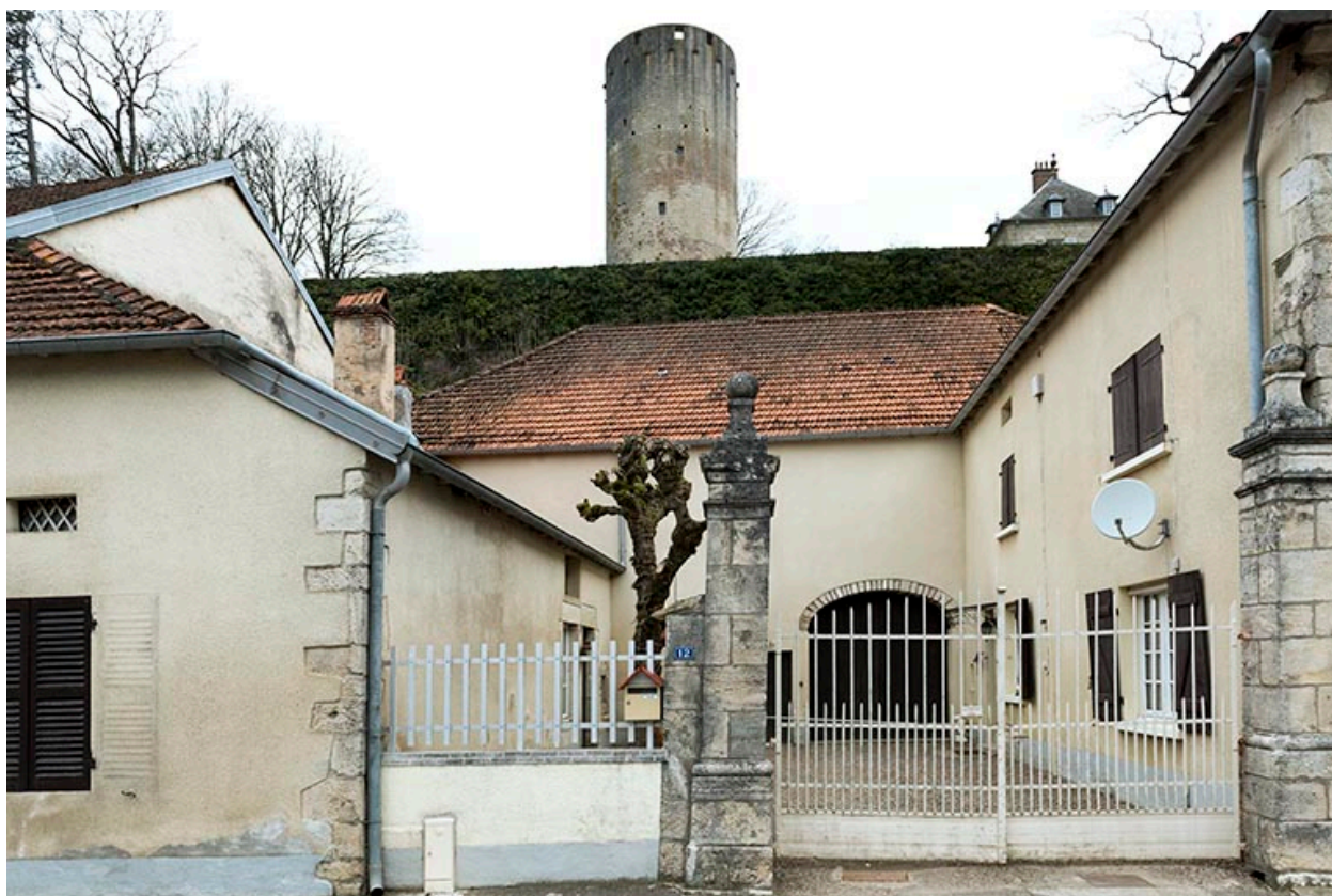
Vue générale depuis la rue du Pâquis
