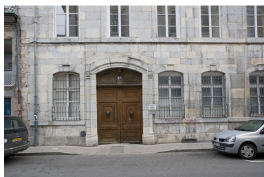
Détail du rez-de-chaussée de la façade principale. Phot. Yves Sancey IVR43_20092500189NUC2A
