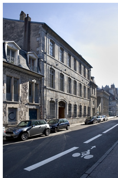
Vue d'ensemble rapprochée de la façade antérieure. Phot. Yves Sancey IVR43_20092500184NUC2A
