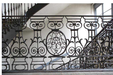
Détail des motifs en fer forgé de la rampe d'escalier. Phot. Yves Sancey IVR43_20092500202NUC2A
