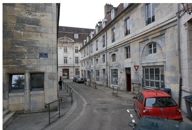
Vue d'ensemble de la façade située sur la rue secondaire. Phot. Yves Sancey IVR43_20092500187NUC2A
