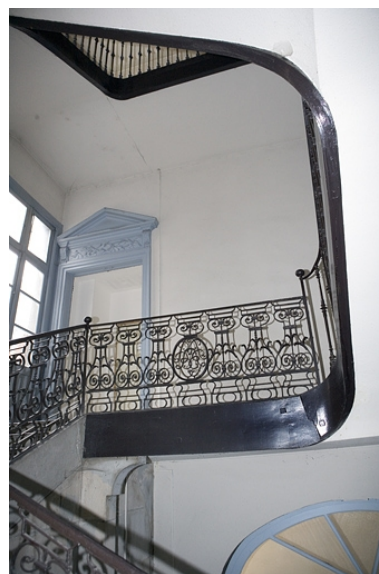
Détail de la rampe de l'escalier. Phot. Yves Sancey IVR43_20092500200NUC2A
