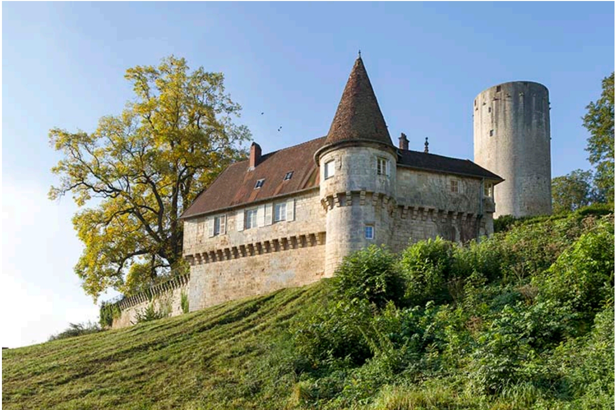
Vue générale depuis le nord.
