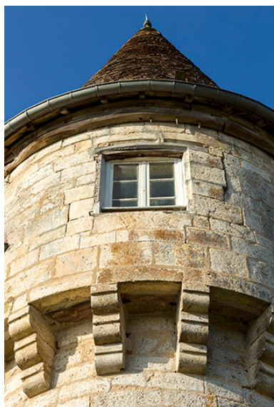
Détail : la tourelle. Phot. Sonia Dourlot IVR43_20167000827NUC2A
