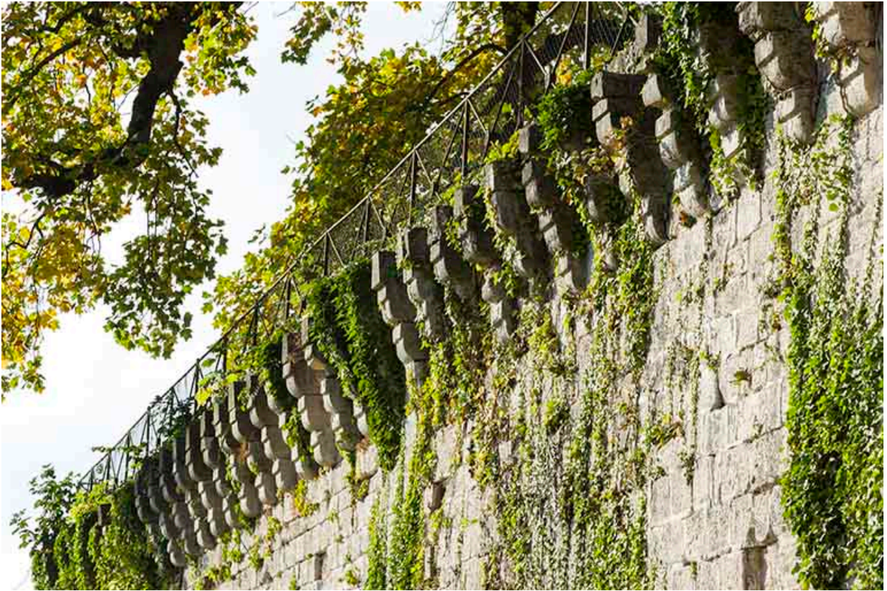
Détail de l'enceinte, au nord-est.
