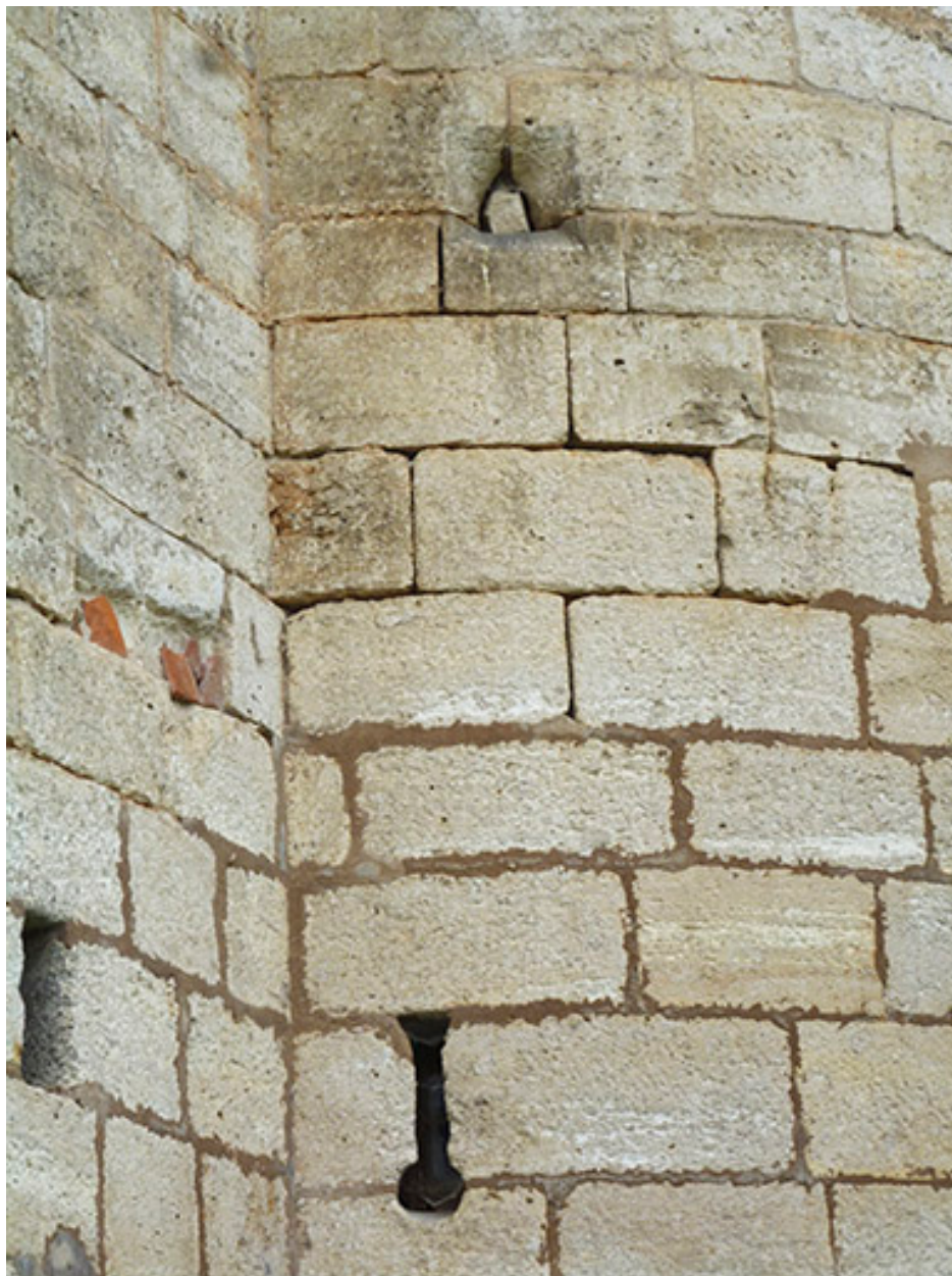
Canonnière du 15e siècle à la base de la tourelle exposée au nord-est.
