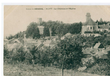
Environs de Vesoul - Rupt - Le château et l'église, 4e quart 19e siècle ou 1er quart 20e siècle ? IVR43_20167001694NUC4A
