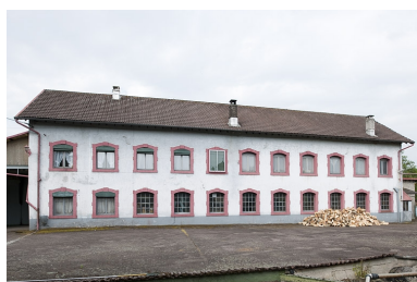
Atelier de fabrication. Façade antérieure. Phot. Jérôme Mongreville IVR43_20122501140NUC4A
