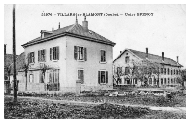
Villars-lès-Blamont - Usine Epenoy. Carte postale, CLB éd., s.n., s.d. [début du 20e siècle]. Phot. Raphaël Favereaux, Autr. IVR43_20122501577NUC2
