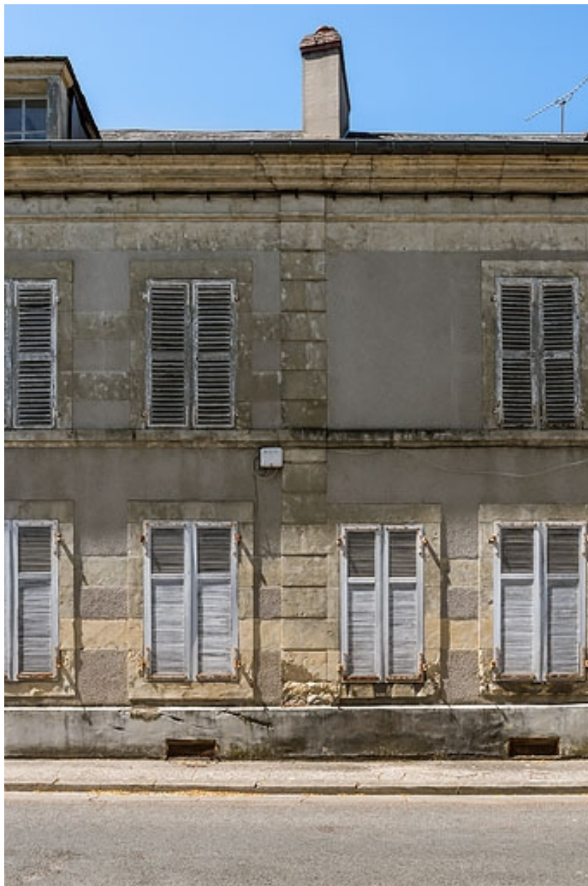
Façade sur la rue du Docteur Jean Pidoux, jambe marquant l'agrandissement de la demeure (à droite).
