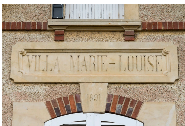
Avant-corps de la façade principale, inscription : "VILLA MARIE-LOUISE". Phot. Pierre-Marie Barbe-Richaud IVR26_20205800570NUC4A
