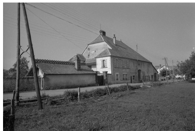
Vue d'ensemble depuis la rue. Phot. Gilbert Poinot IVR43_19762500894Z
