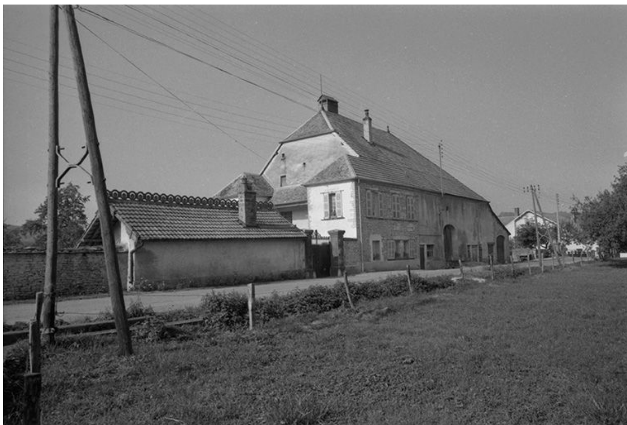
Vue d'ensemble depuis la rue.
