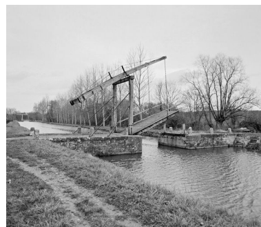
Le pont en cours de levage. Vue de l'amont. Phot. Jean-Luc Duthu IVR26_19925800274X
