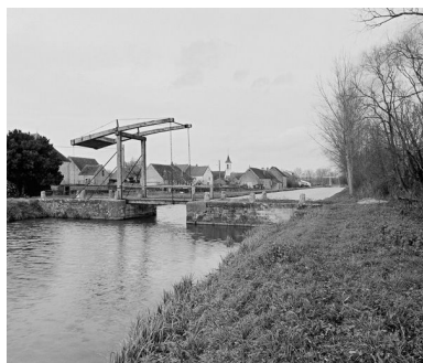
Vue d'ensemble. Phot. Jean-Luc Duthu IVR26_19925800271X
