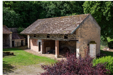
Le bâtiment du séchoir, de trois quarts. Phot. Nicolas Waltefaugle IVR26_20268900219NUC4A
