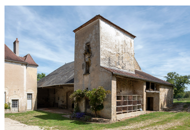
Le colombier, les cages à lapin et la bergerie. Phot. Nicolas Waltefaugle IVR26_20268900227NUC4A
