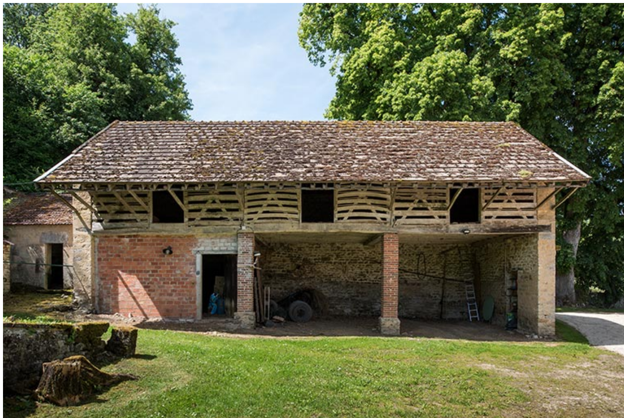
Le bâtiment du séchoir, de face.
