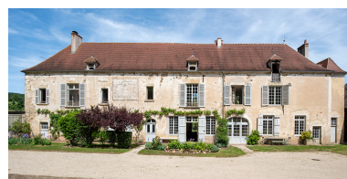
La façade avant de la demeure, sur cour. Phot. Nicolas Waltefaugle IVR26_20268900228NUC4A
