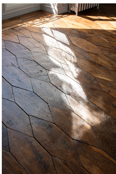
La première chambre de l'étage, côté nord. Détail du parquet. Phot. Nicolas Waltefaugle IVR26_20268900218NUC4A
