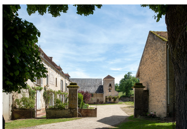
L'ensemble de la cour depuis l'entrée. Phot. Nicolas Waltefaugle IVR26_20268900231NUC4A
