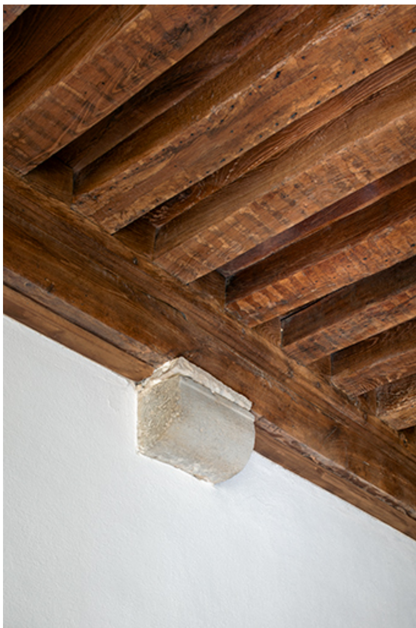
Grande salle, détail du plafond et de l'un des corbeaux.
