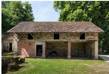
Le bâtiment du séchoir, de face. Phot. Nicolas Waltefaugle IVR26_20268900229NUC4A
