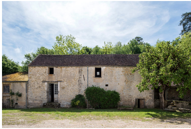
Bâtiments agricoles au sud de la cour. Phot. Nicolas Waltefaugle IVR26_20268900233NUC4A
