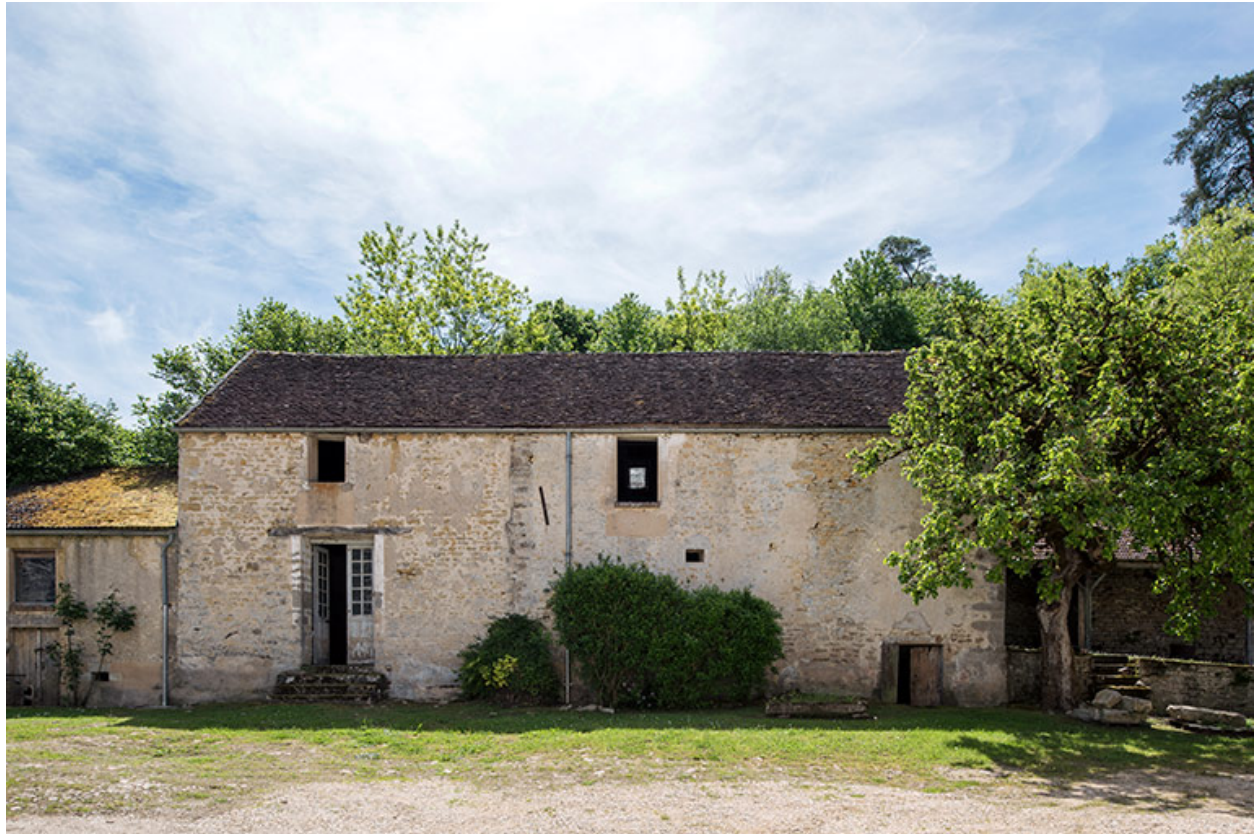
Bâtiments agricoles au sud de la cour.
