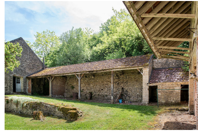
L'appentis et deux toits à porcs. Phot. Nicolas Waltefaugle IVR26_20268900230NUC4A
