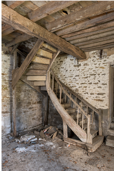
Bâtiments agricoles au sud de la cour : accès au grenier. Phot. Nicolas Waltefaugle IVR26_20268900226NUC4A
