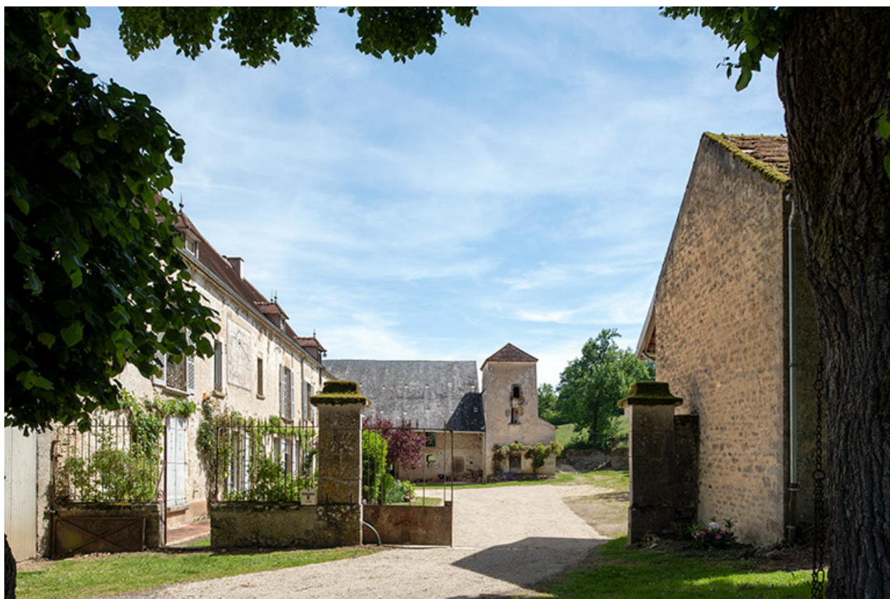
L'ensemble de la cour depuis l'entrée.
