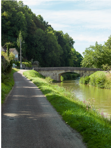
Vue du pont.
