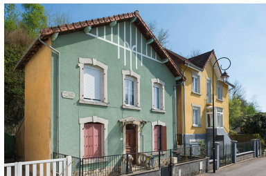
Vue d'ensemble. Phot. Jérôme Mongreville IVR43_20177000506NUC4A
