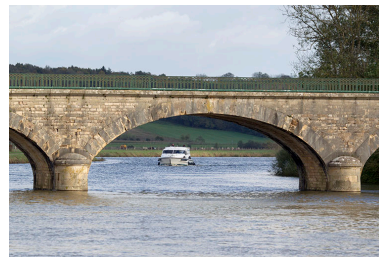
Détail d'une arche maçonnée du pont. Phot. Sonia Dourlot IVR43_20157000125NUC2A
