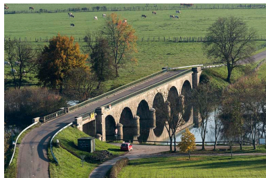
Vue générale du pont depuis le château de Rupt-sur-Saône. Phot. Sonia Dourlot IVR43_20167000296NUC4A
