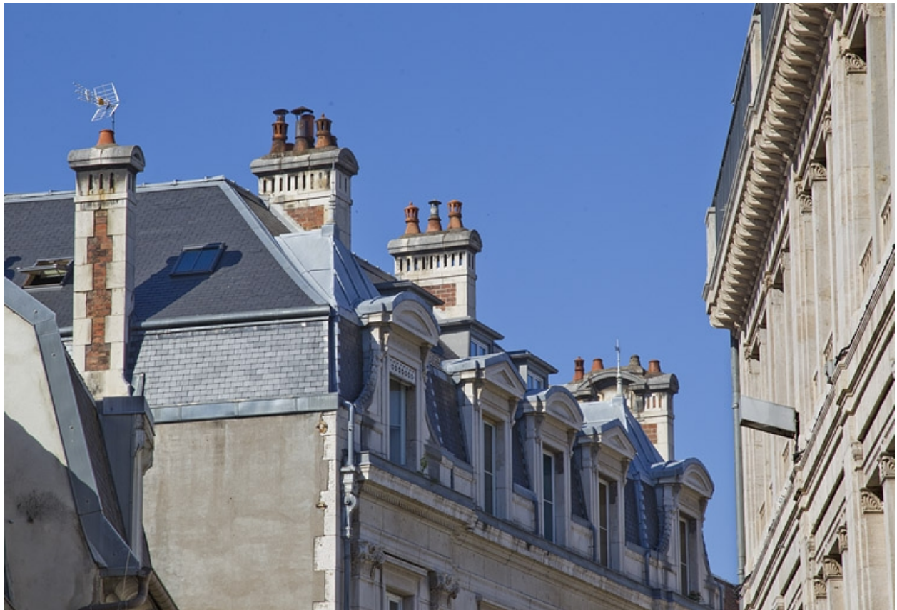
Logis principal : détail de l'étage de comble.
