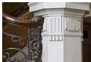
détail de la date (1890). Phot. Yves Sancey IVR43_20112501075NUC2A
