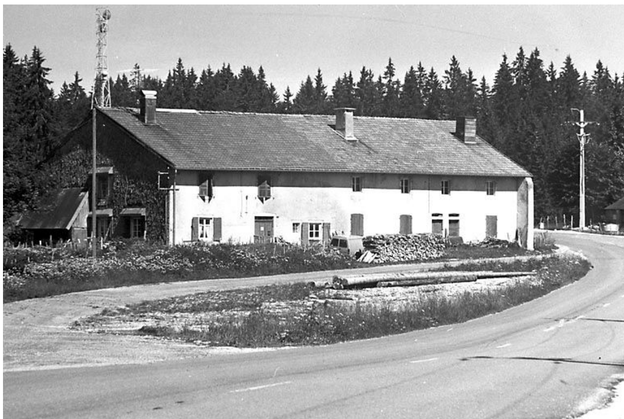
Vue éloignée de la façade antérieure.
