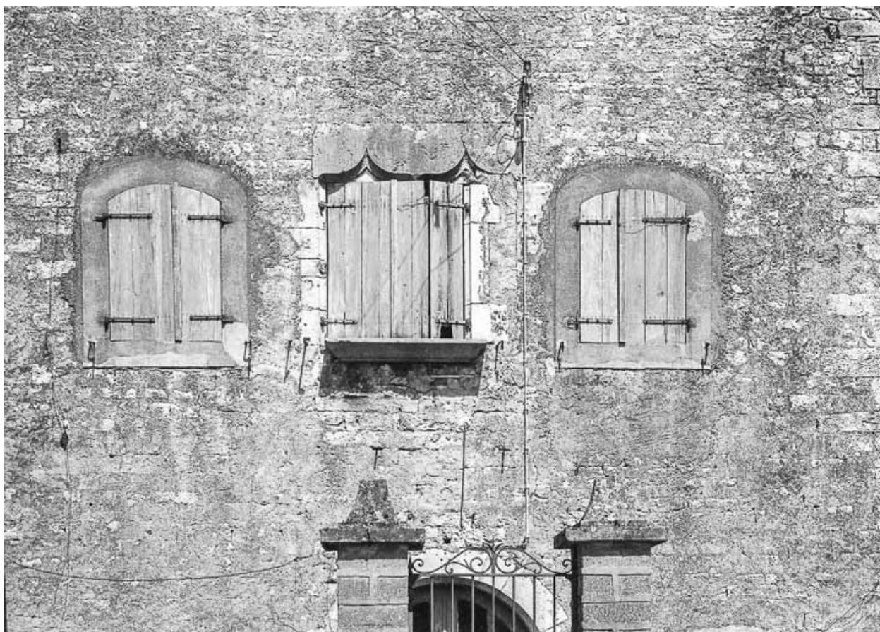
Mur en moellons calcaires recouverts d'enduit
