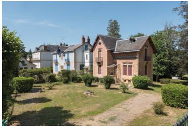
Vue de la villa (à l'extrémité gauche) à côté de la Villa Diana et de Villa Les Sorbiers. Phot. Pierre-Marie Barbe-Richaud IVR26_20195800476NUC4A
