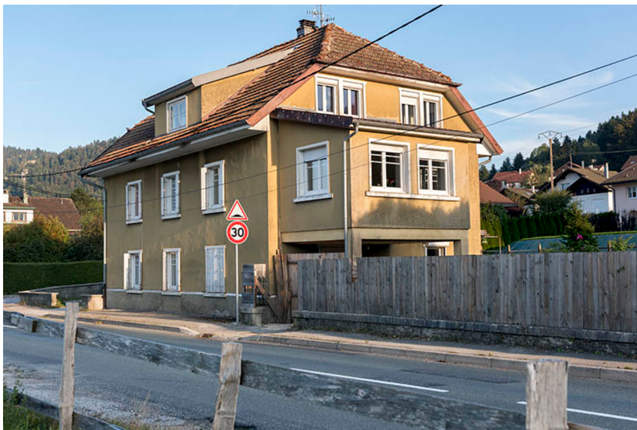
Façades antérieure et latérale droite.
