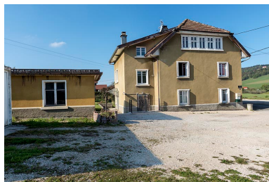
Garage et façade latérale gauche. Phot. Sonia Dourlot IVR43_20162501709NUC4A
