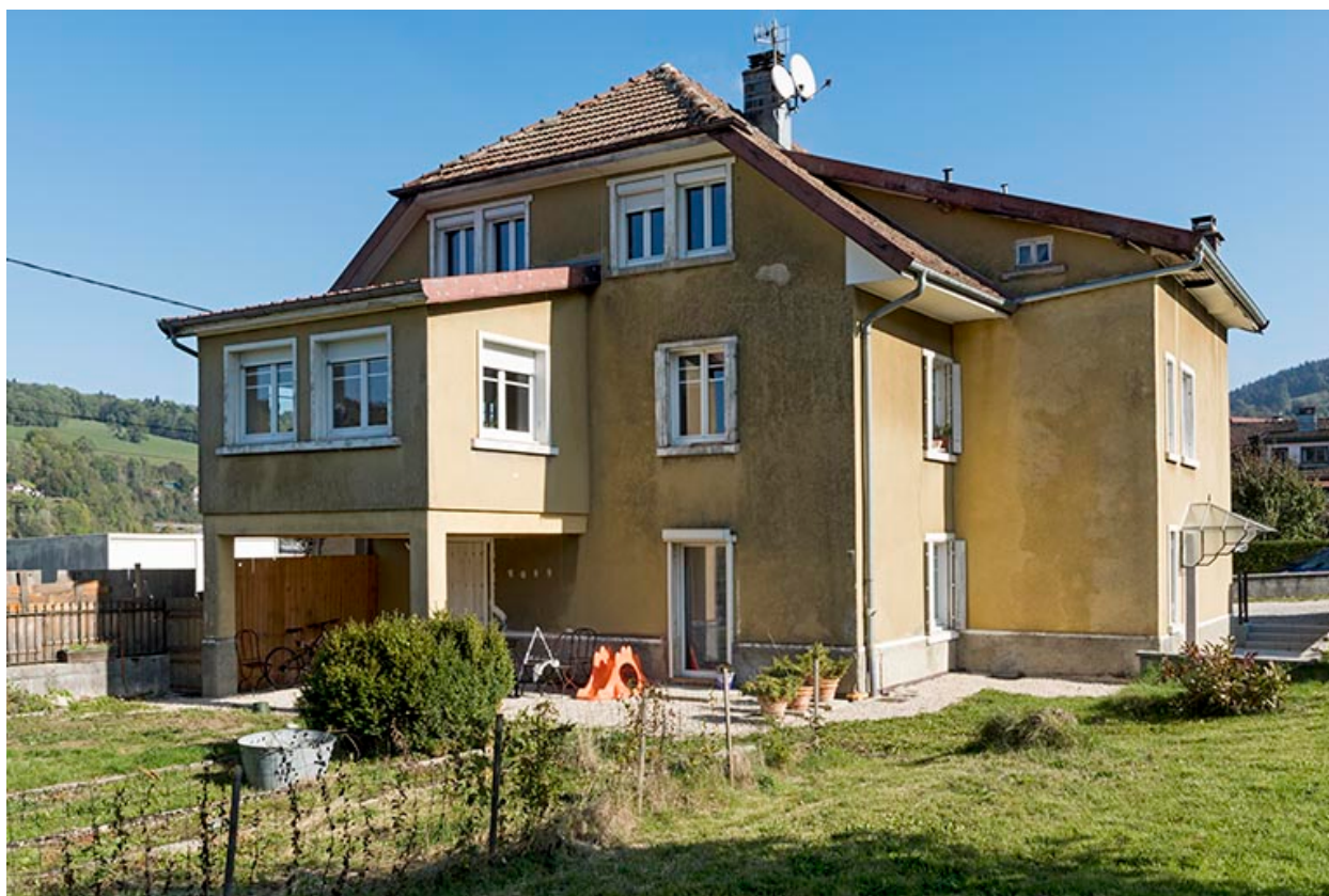
Façade latérale droite, de trois quarts droite.
