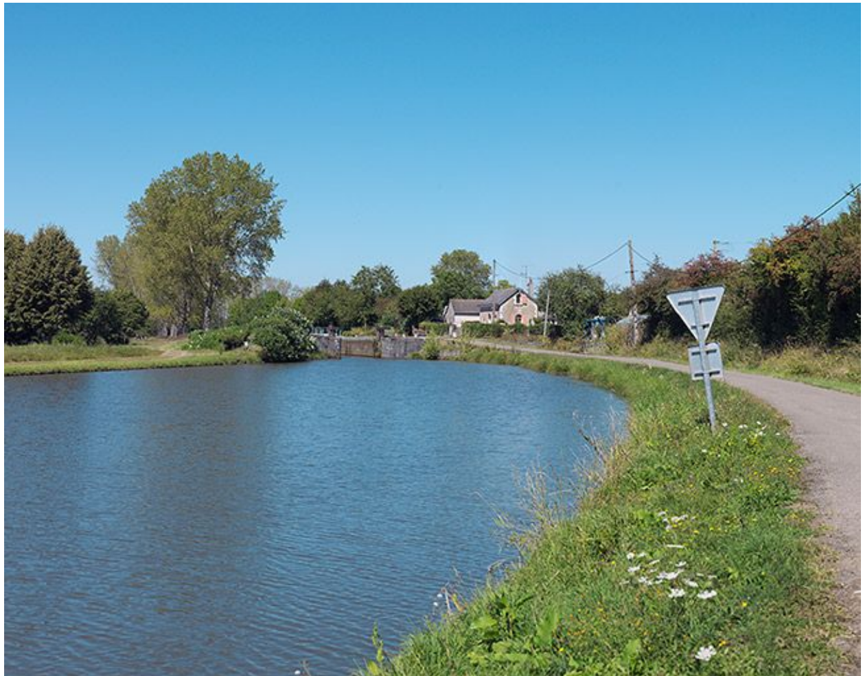
Vue d'ensemble du site prise d'aval.
