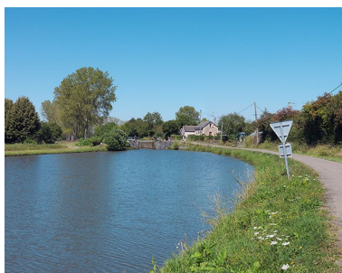
Vue d'ensemble du site prise d'aval.
