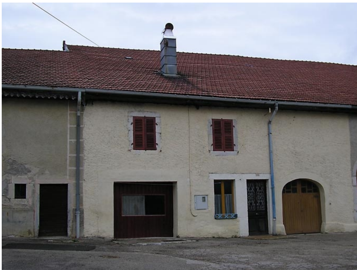
Vue latérale de la façade antérieure.
