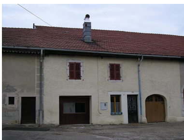
Vue latérale de la façade antérieure.
