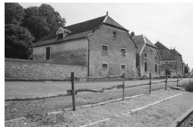
Façades sur rue. Phot. Bernard Lardière IVR43_19797000258Z
