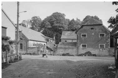
Vue d'ensemble. Phot. Bernard Lardière IVR43_19797000259Z
