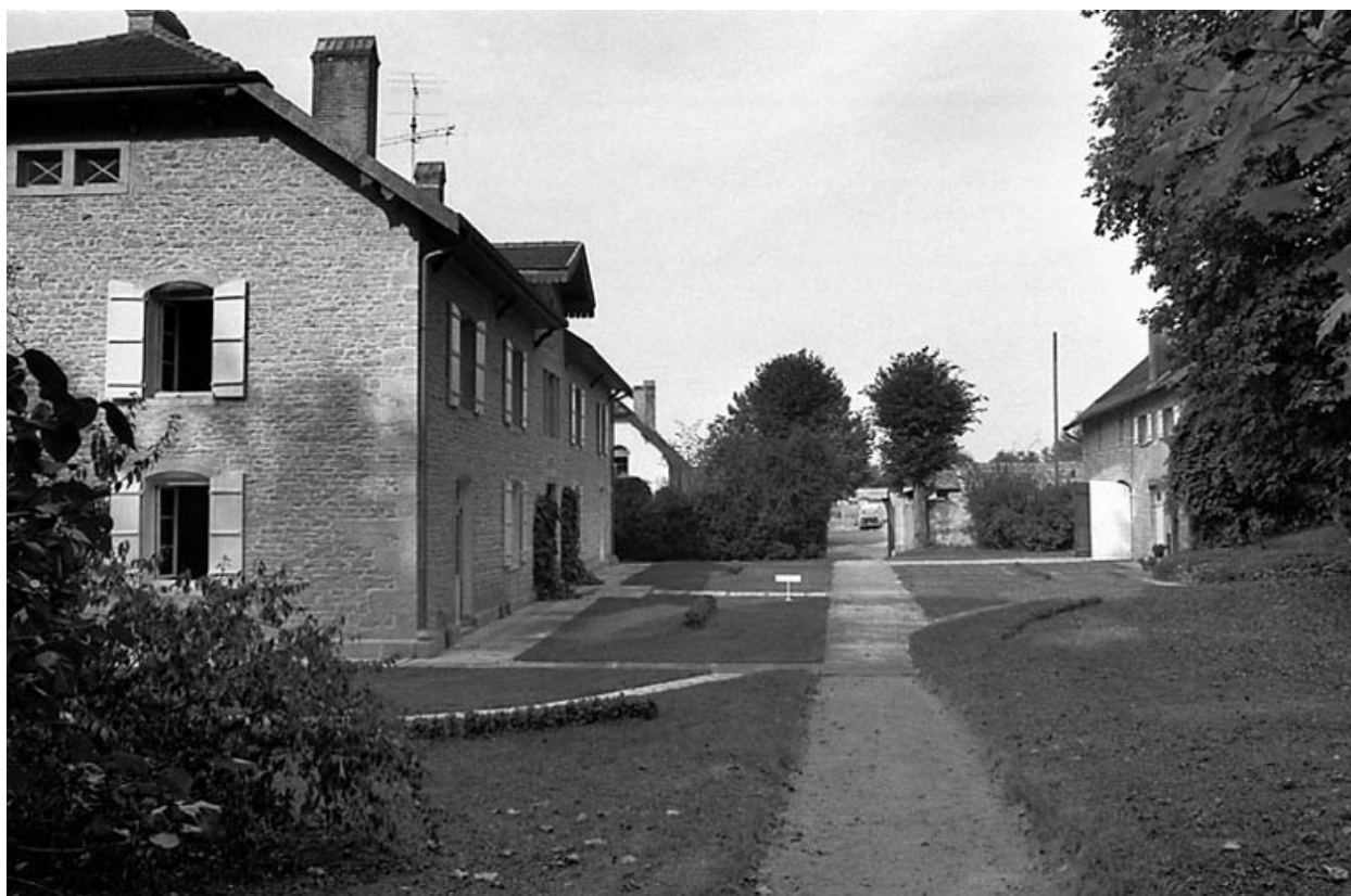
Façades sur cour.
