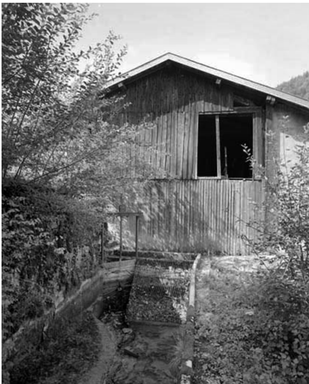
Canal d'amenée et bâtiment d'eau (ancienne scierie).
