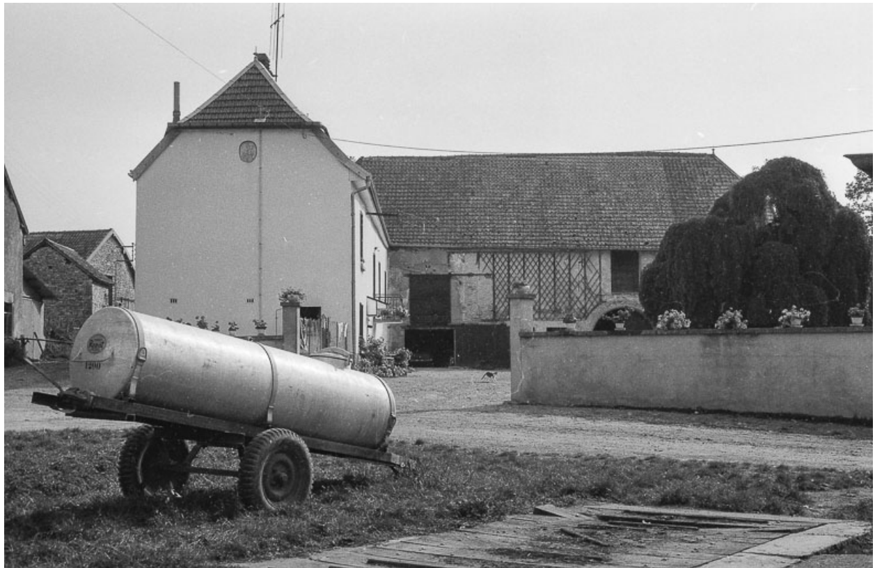
Vue d'ensemble depuis la rue.
