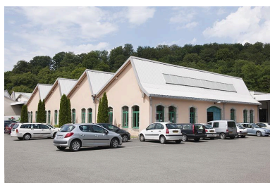
Atelier d'outillage depuis le sud. Phot. Jérôme Mongreville IVR43_20112502301NUC4A
