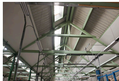
Charpente de l'atelier de finition. Phot. Jérôme Mongreville IVR43_20112502324NUC4A
