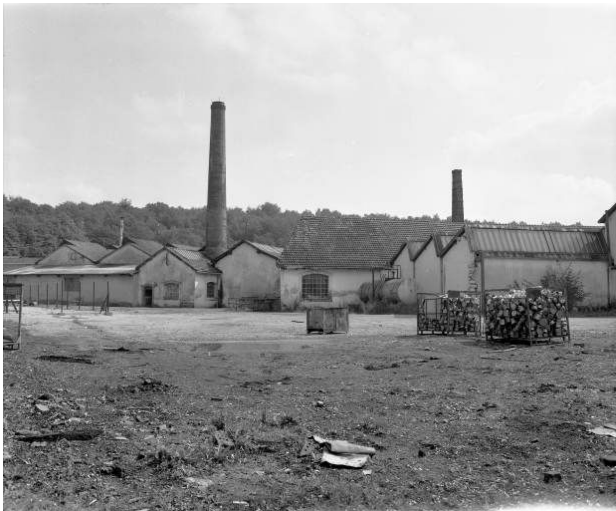
Ateliers de fabrication depuis l'ouest en 1981.
