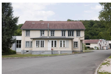
Ancien bâtiment des bureaux. Façade sud. Phot. Jérôme Mongreville IVR43_20112502306NUC4A
