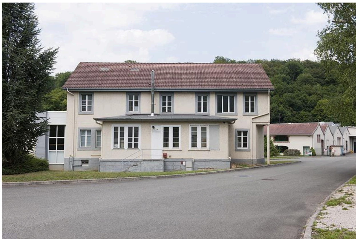
Ancien bâtiment des bureaux. Façade sud.
