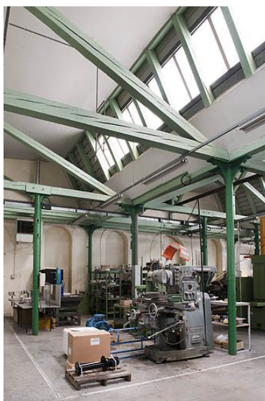
Atelier d'outillage. Détail de la charpente. Phot. Jérôme Mongreville IVR43_20112502308NUC4A
