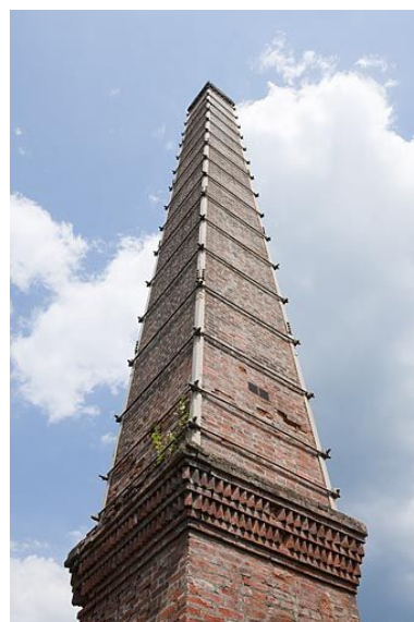
La cheminée carrée. Phot. Jérôme Mongreville IVR43_20112502300NUC4A
