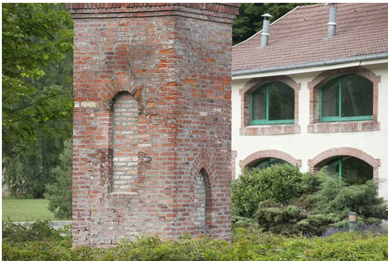
Soubassement de la cheminée carrée.
