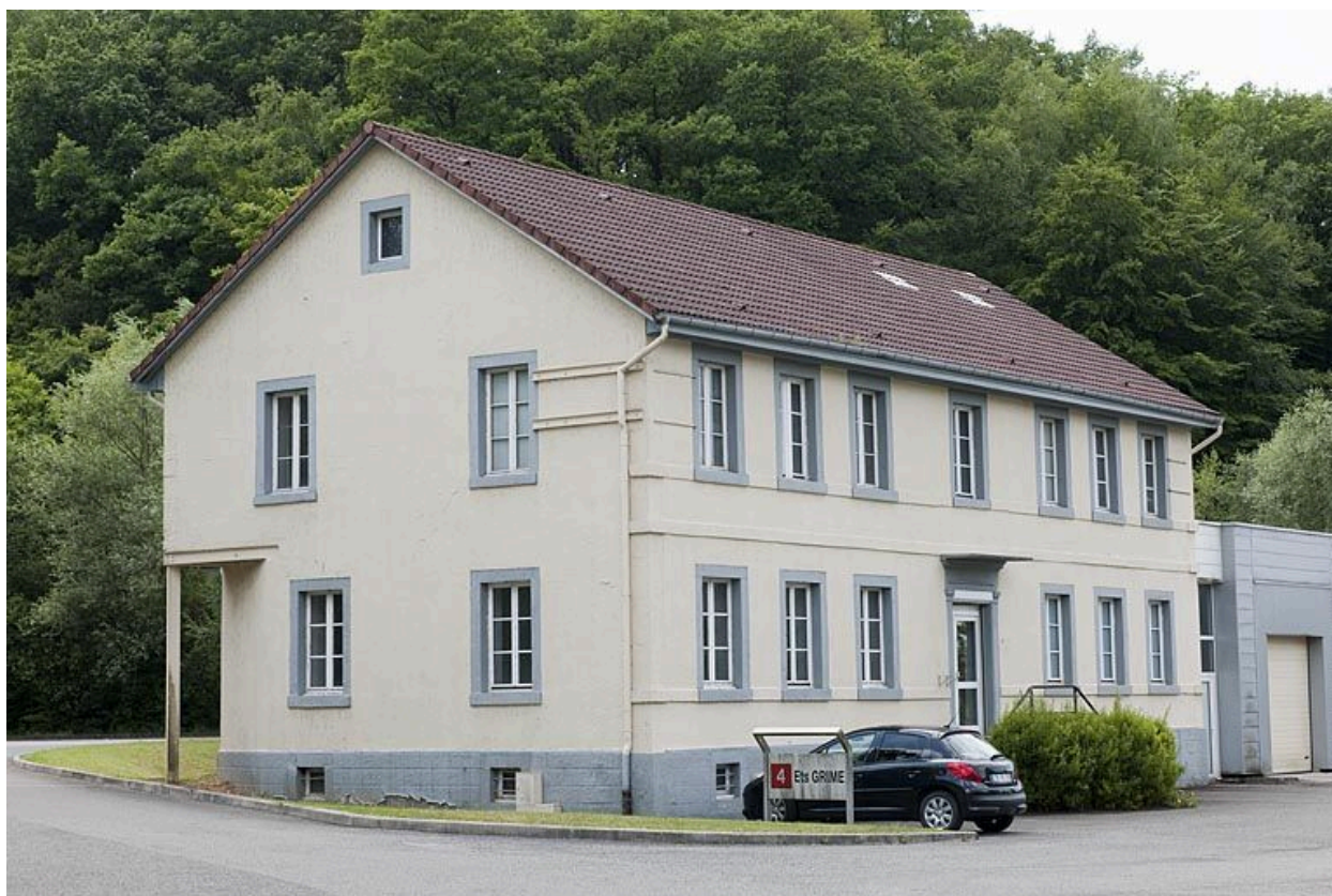
Ancien bâtiment des bureaux. Façade nord.
