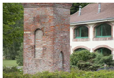
Soubassement de la cheminée carrée. Phot. Jérôme Mongreville IVR43_20112502294NUC4A
