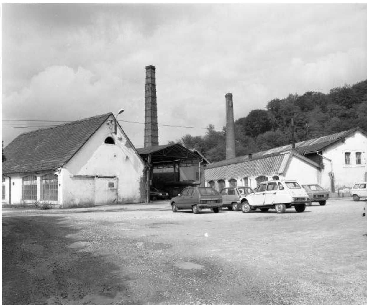
Ateliers de fabrication depuis l'est en 1981.
