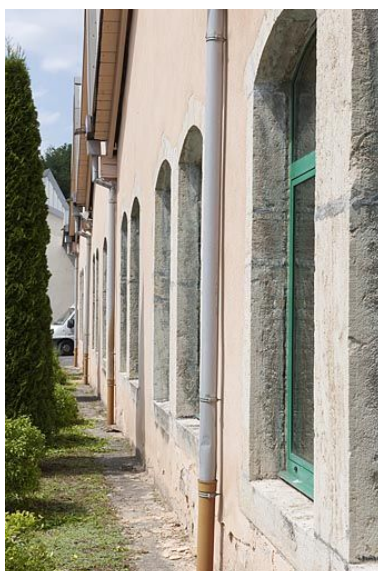
Façade ouest de l'atelier d'outillage. Phot. Jérôme Mongreville IVR43_20112502303NUC4A
