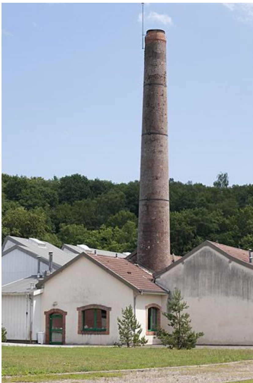
Cheminée et pignons nord des ateliers.
