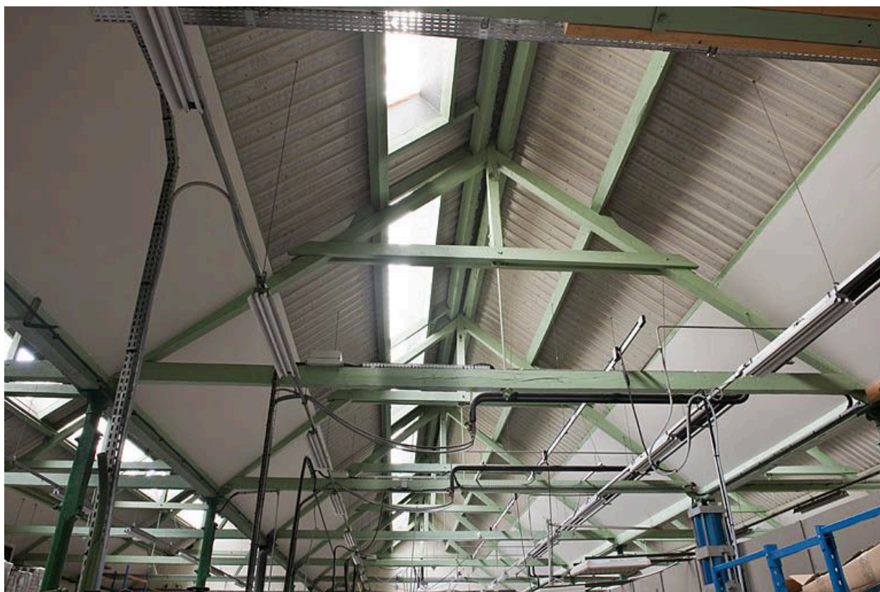
Charpente de l'atelier de finition.
