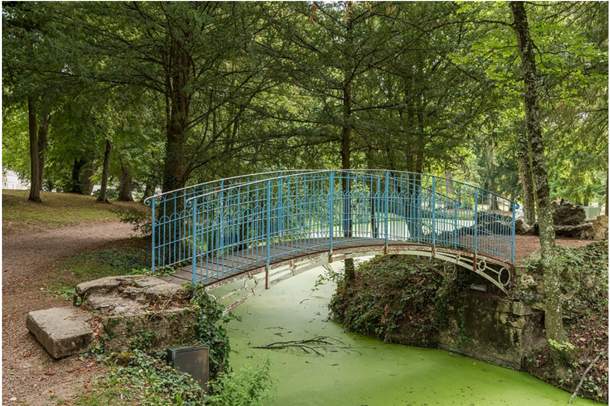
Passerelle métallique donnant accès à l'île.
