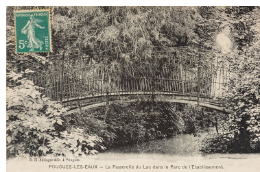
Passerelle métallique donnant accès à l'île (état au début du 20e siècle). Autr. auteur inconnu IVR26_20205800039NUC4A
