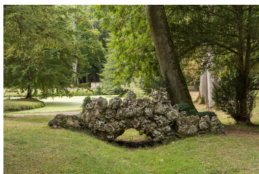
Pont rustique. Phot. Pierre-Marie Barbe-Richaud IVR26_20205800587NUC4A
