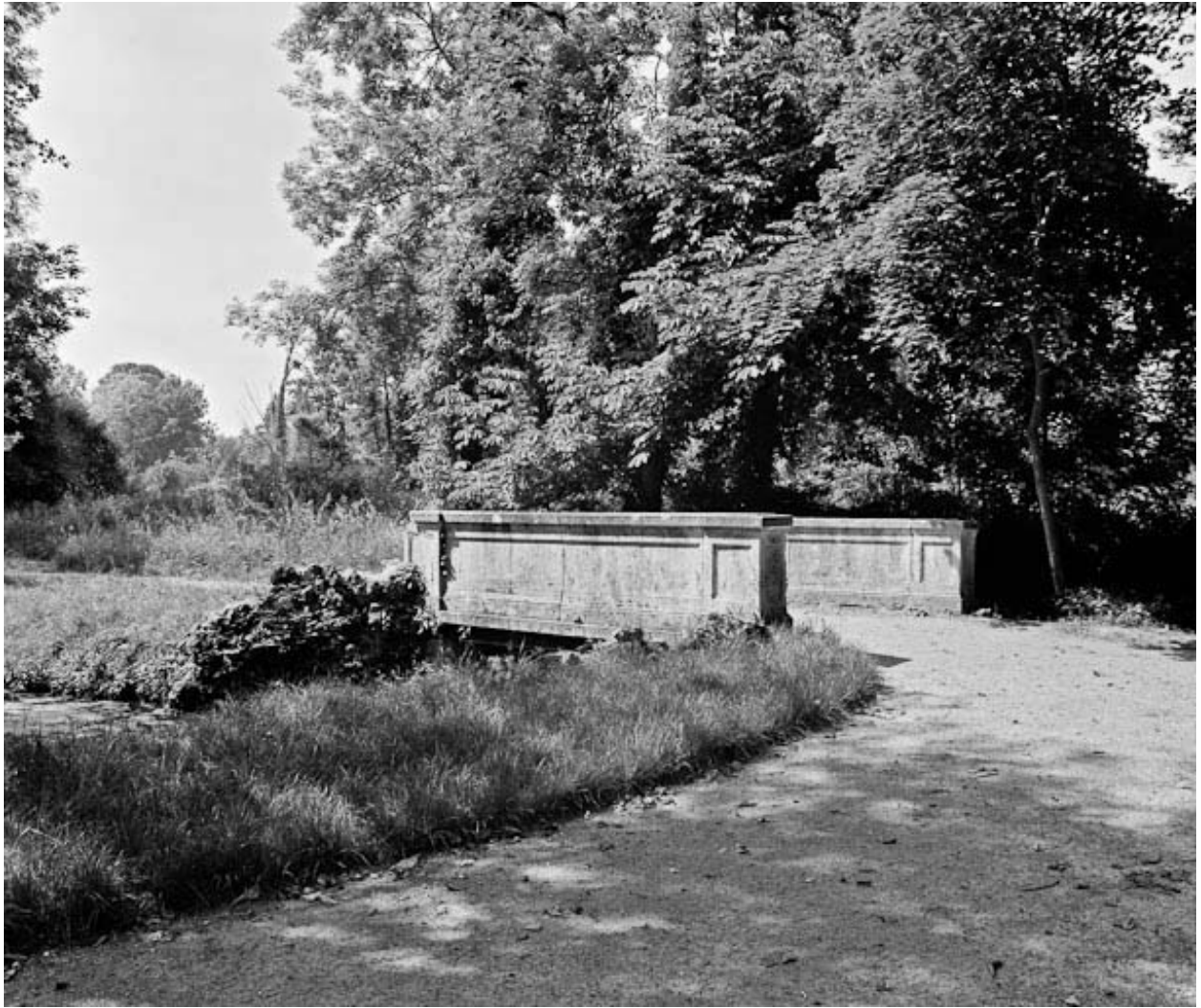
Pont de pierre au nord du lac (état en 1984).
