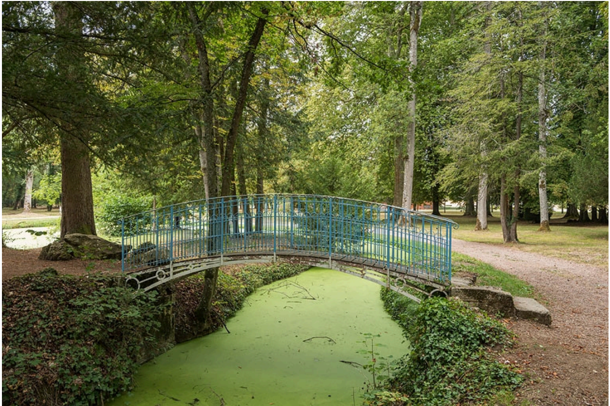
Passerelle métallique donnant accès à l'île.
