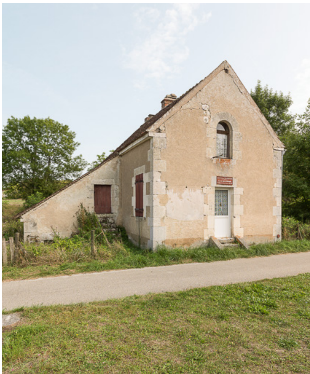
Vue de la maison éclusière.
