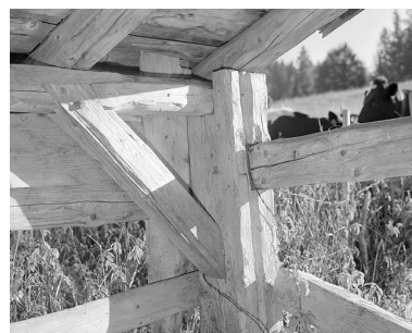
Assemblage de la charpente de l'abreuvoir. Phot. Jérôme Mongreville IVR43_19963901472X
