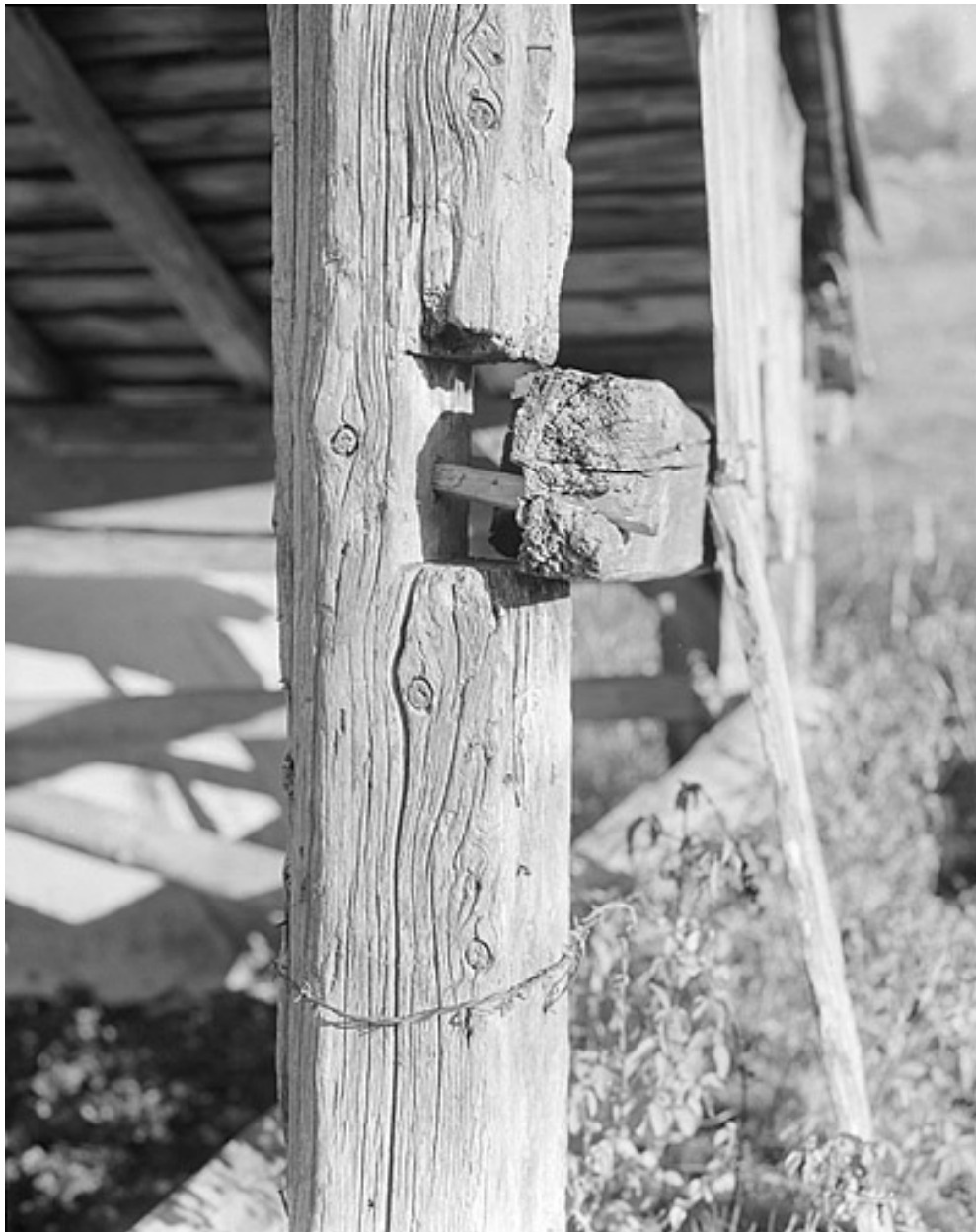
Assemblage à mi-bois poteaux-panne par une cheville.
