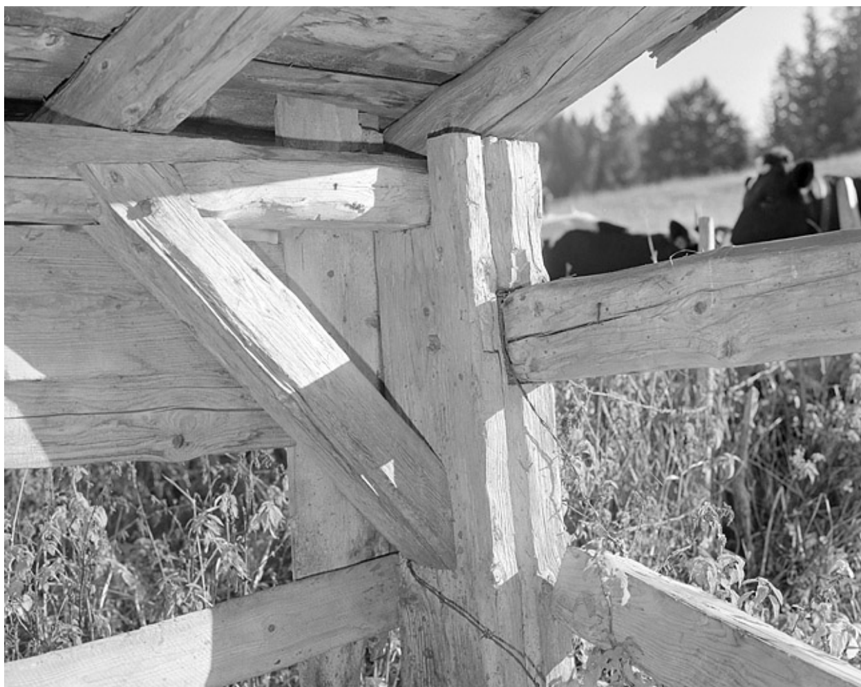
Assemblage de la charpente de l'abreuvoir.
