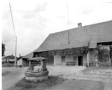
Façade antérieure. Phot. Dominique Dominguez IVR43_19773900053X
