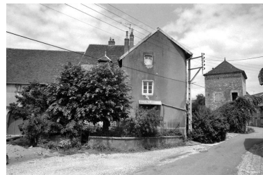
Façade latérale gauche. Phot. Bernard Lardière IVR43_19817000508Z
