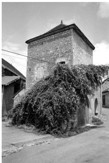
Vue du pigeonnier. Phot. Bernard Lardière IVR43_19817000509Z
