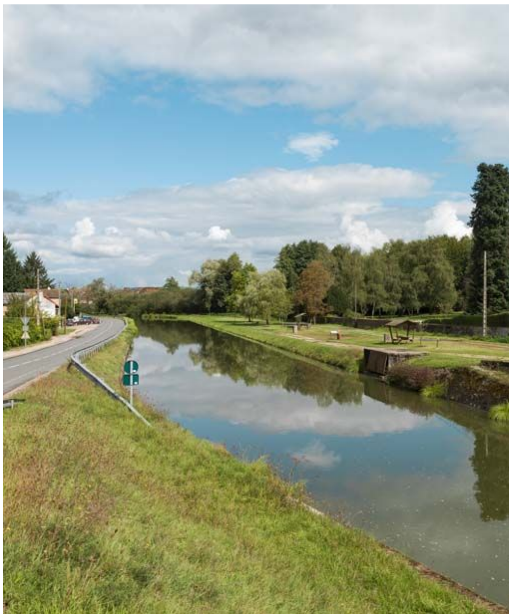
Vue d'ensemble du port.
