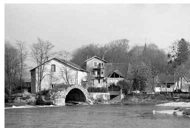
Façade antérieure. Phot. Laurent Poupard IVR43_19903901031Z
