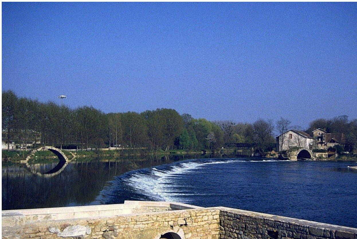
Vue d'ensemble depuis le moulin à bateau, à l'ouest.
