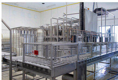
Atelier de fabrication : extrémité du convoyeur côté presse tournante. Phot. Sonia Dourlot IVR43_20142500742NUC2A
