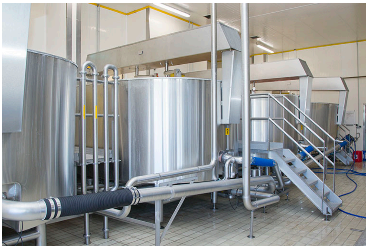
Atelier de fabrication : les quatre cuves.
