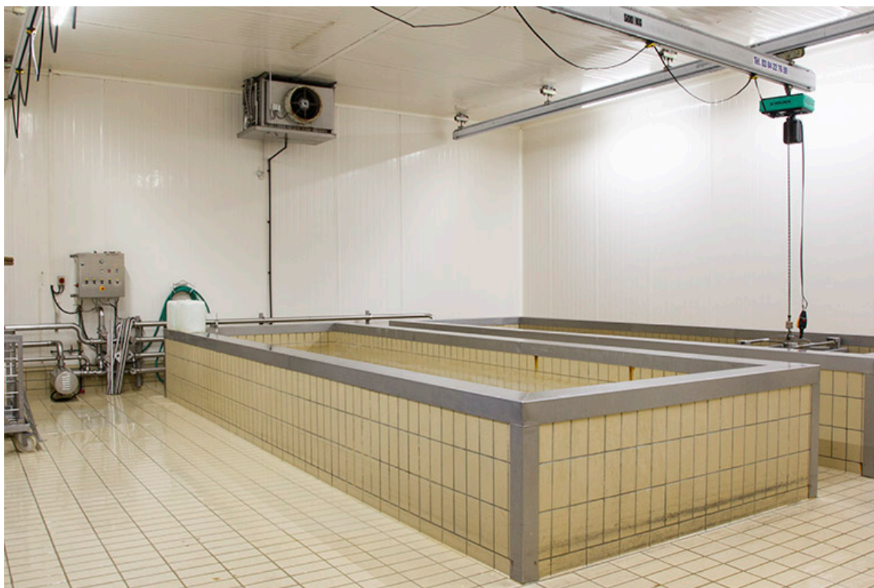
Atelier de saumurage : vue d'ensemble.
