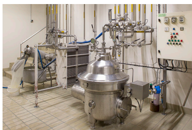
Salle de la station de lavage CIP : débourbeuse (à droite) et filtre à sérum. Phot. Sonia Dourlot IVR43_20142500758NUC2A
