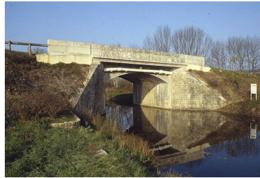
Vue d'ensemble prise de l'aval. Phot. Jean-Luc Duthu IVR26_19935800789ZA
