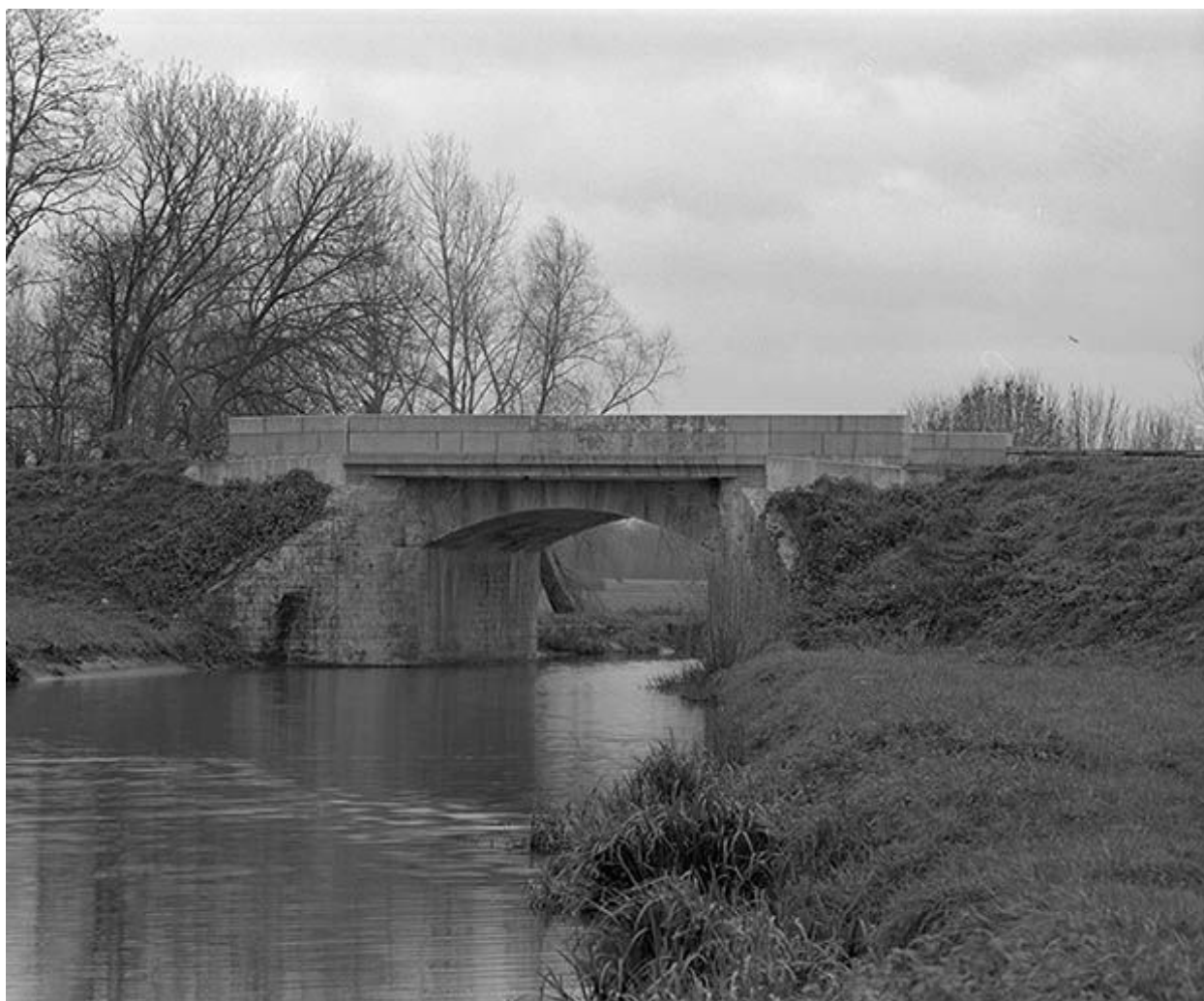
Vue d'ensemble prise de l'aval
