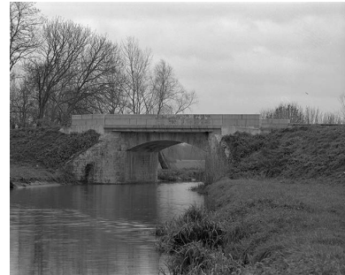
Vue d'ensemble prise de l'aval Phot. Jean-Luc Duthu IVR26_19925800236X
