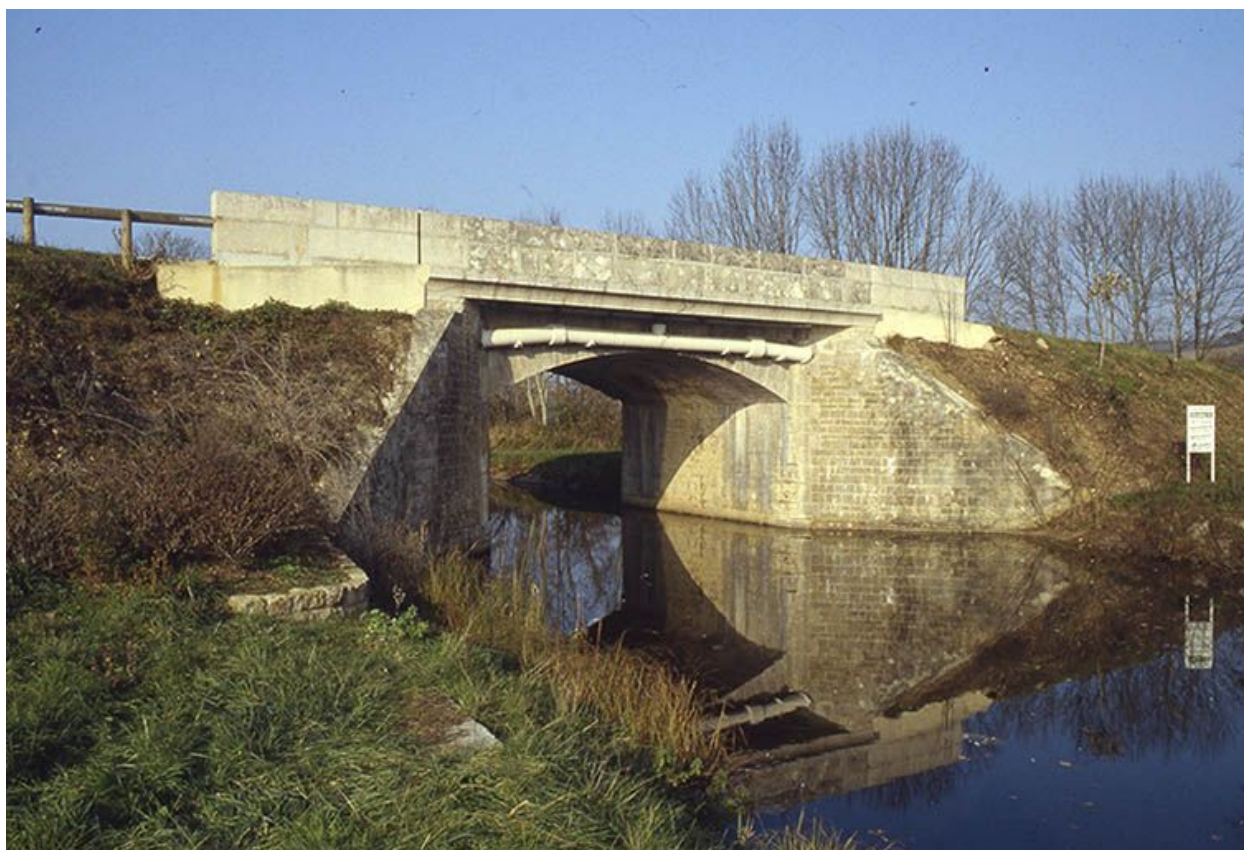
Vue d'ensemble prise de l'aval.
