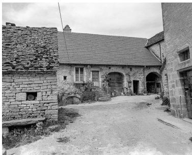
Façade antérieure en 1981. Phot. Yves Sancey IVR43_19813900021X
