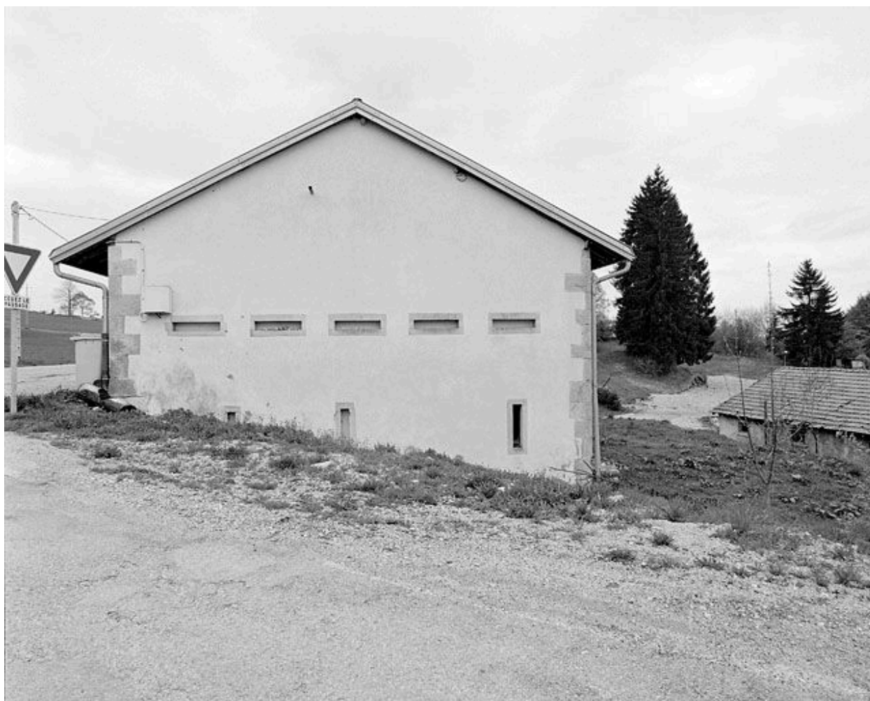
Façade droite de la fromagerie.
