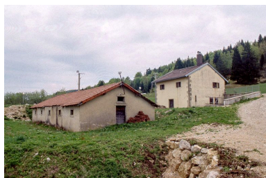
Façades postérieures et latérales gauches de la fromagerie et de la porcherie. Phot. Yves Sancey IVR43_19993900276ZA
