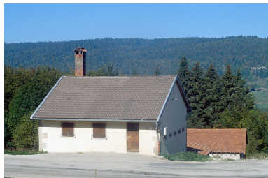
Vue d'ensemble de la fromagerie. IVR43_19903900536ZA
