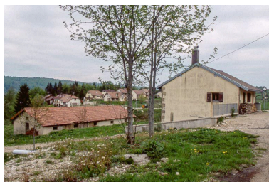
Façades antérieures et latérales droites de la fromagerie et de la porcherie. Phot. Yves Sancey IVR43_19993900278ZA
