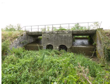
Vue du déversoir.
