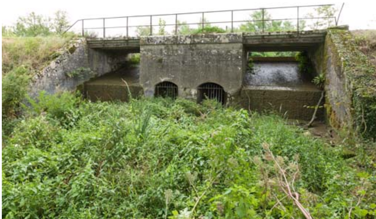
Vue du déversoir.
