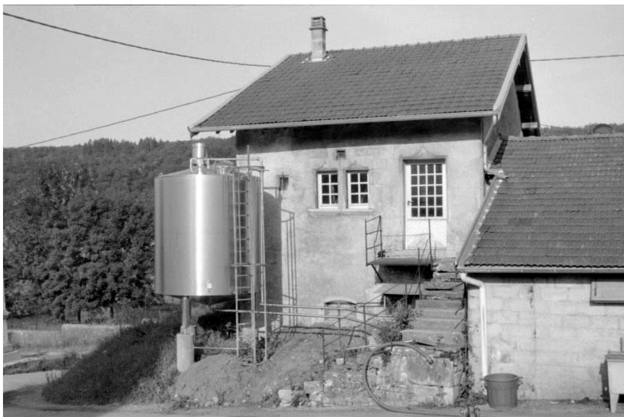
Façade postérieure de la maison.
