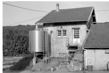
Façade postérieure de la maison. Phot. Laurent Poupard IVR43_19923901301Z
