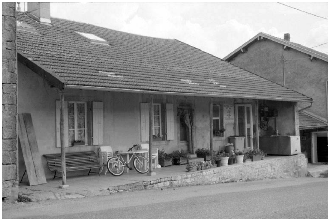
Façade antérieure de la fromagerie.
