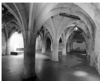
Sous-sol de l'aile droite : vue d'ensemble depuis l'entrée, partie droite. Phot. Yves Sancey IVR43_20022500210X
