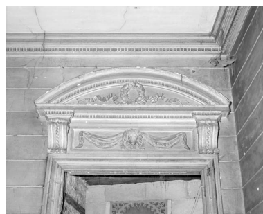
Intérieur : escalier d'honneur, porte gauche sur le palier, détail du fronton. Phot. Yves Sancey IVR43_20012500233X
