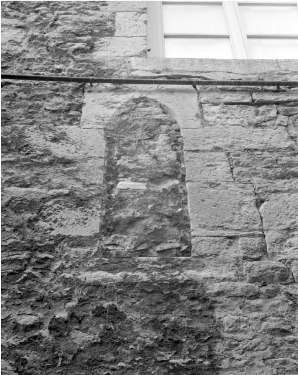
Façade latérale gauche : détail d'une baie murée.
