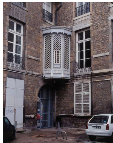
Façade antérieure sur cour : détail de l'angle gauche. Phot. Yves Sancey IVR43_20012500238XA
