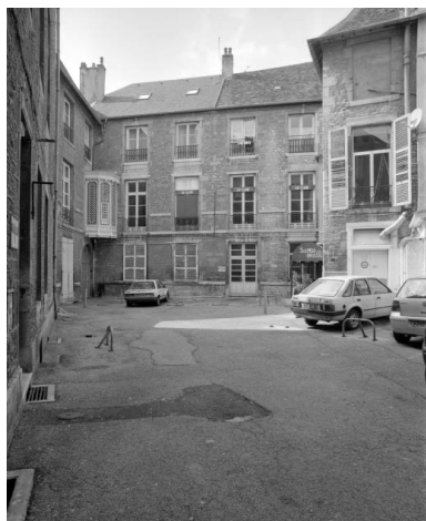
Vue d'ensemble de la façade antérieure du logis principal en fond de cour. Phot. Yves Sancey IVR43_20022500207X
