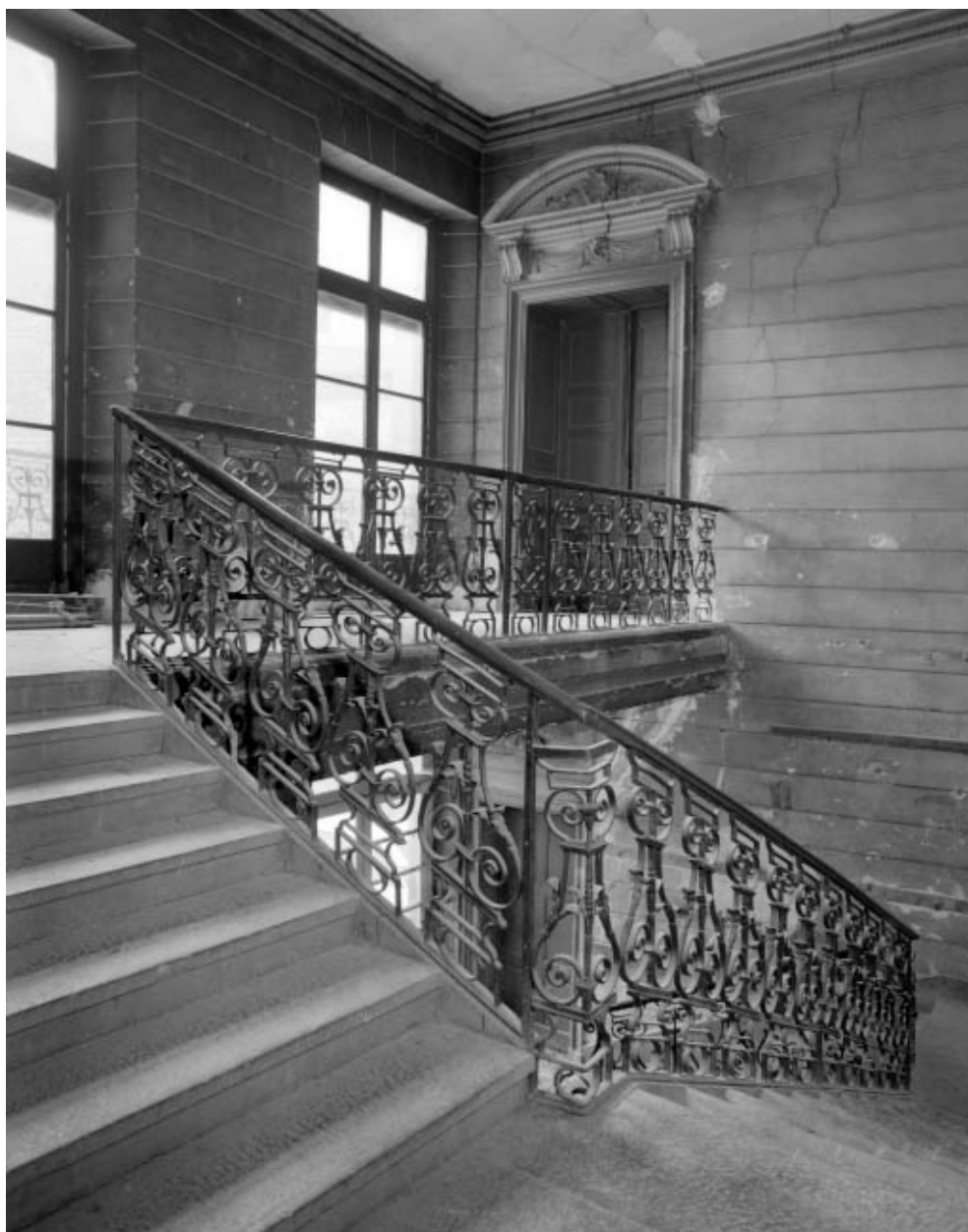
Intérieur : escalier d'honneur, vue d'ensemble depuis le repos.
