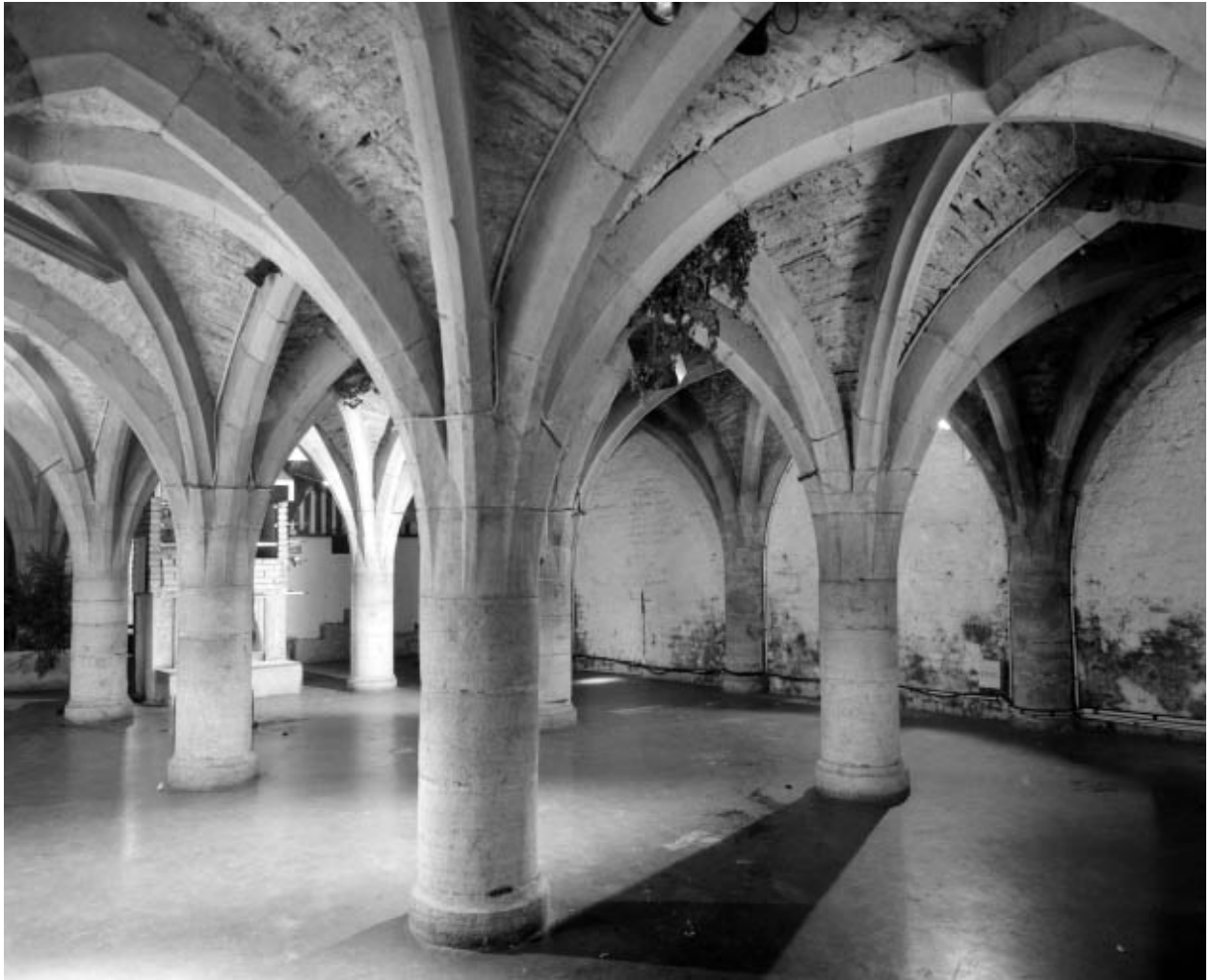
Sous-sol de l'aile droite : vue d'ensemble depuis l'entrée, de trois-quart droit.
