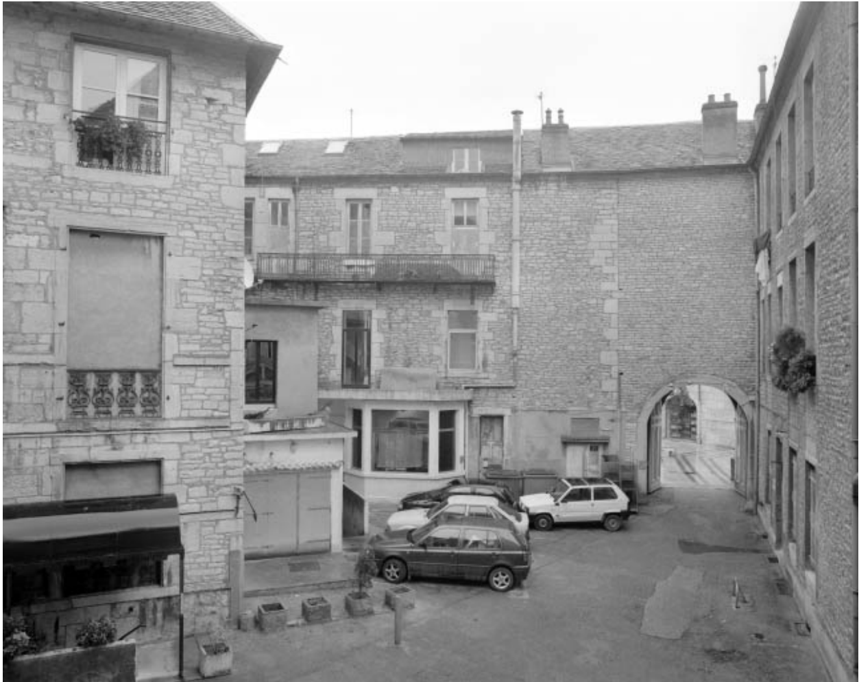
Vue de la cour antérieure depuis le logis sur cour, de trois-quart gauche.
