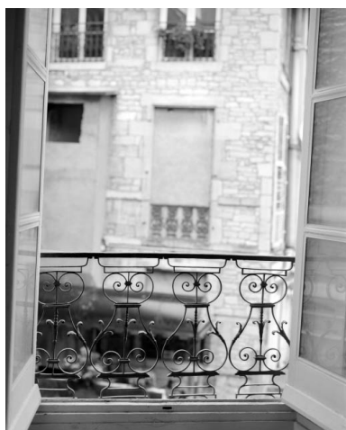
Façade antérieure sur cour : détail de la ferronnerie d'un garde-corps. Phot. Yves Sancey IVR43_20012500239X
