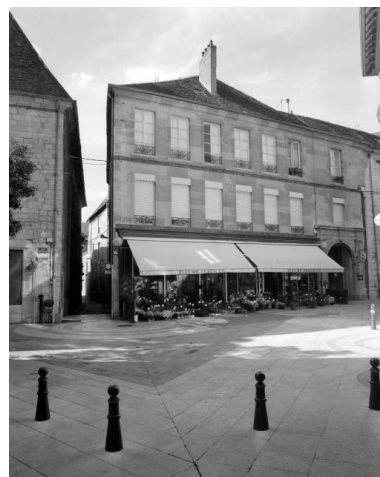
Façade sur rue : détail de la partie gauche. Phot. Yves Sancey IVR43_20012500245X
