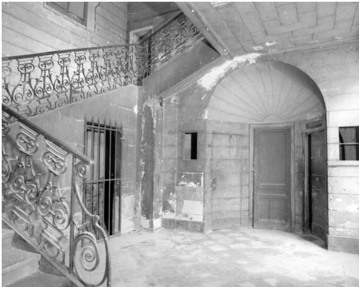
Intérieur : escalier d'honneur, vue d'ensemble en largeur.
