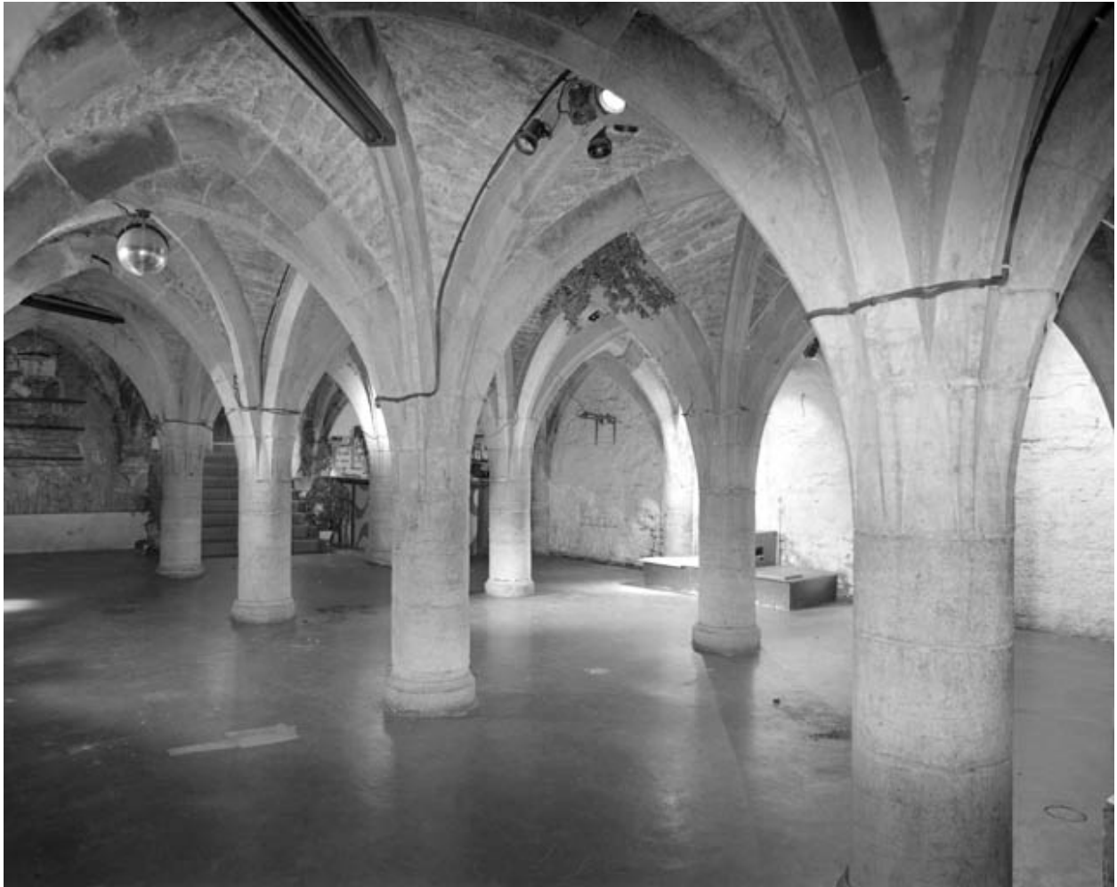
Sous-sol de l'aile droite : vue d'ensemble depuis le fond.
