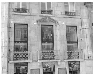
Façade sur rue, détail du premier étage de la partie droite. Phot. Yves Sancey IVR43_20012500211X
