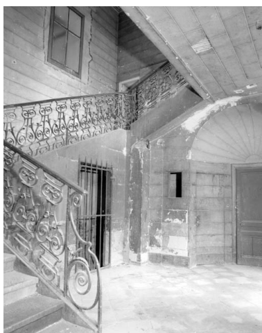
Intérieur : escalier d'honneur, vue d'ensemble en hauteur. Phot. Yves Sancey IVR43_20012500229X
