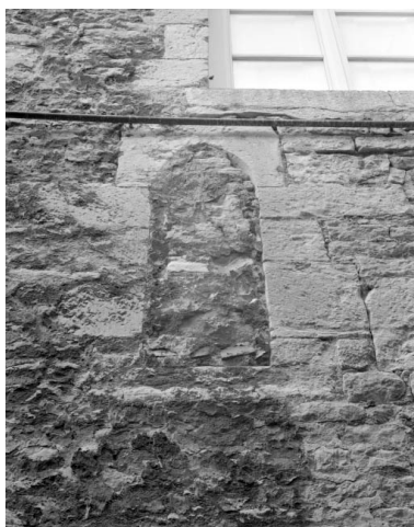
Façade latérale gauche : détail d'une baie murée. Phot. Yves Sancey IVR43_20012500251X
