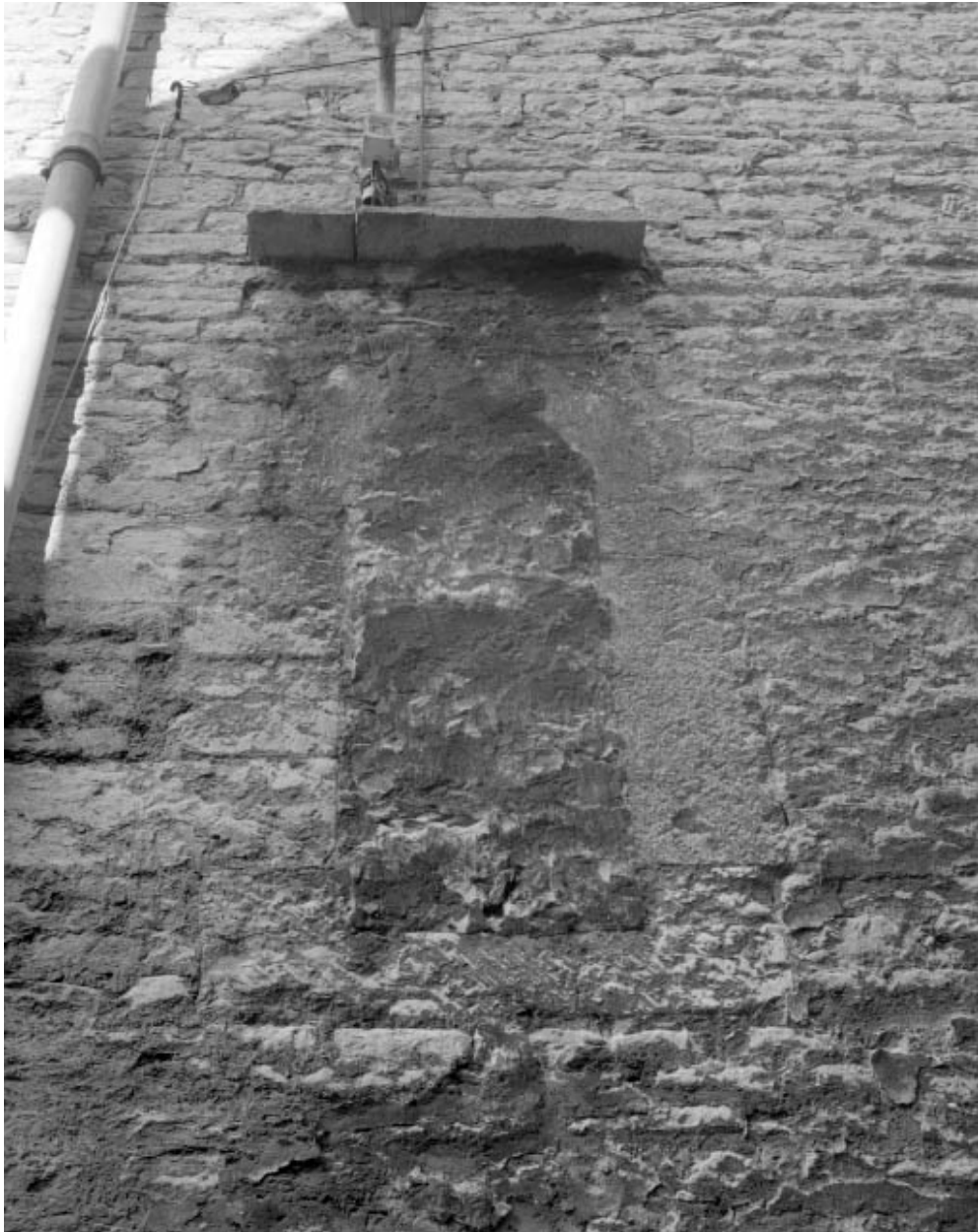
Façade latérale gauche : détail d'une baie murée.
