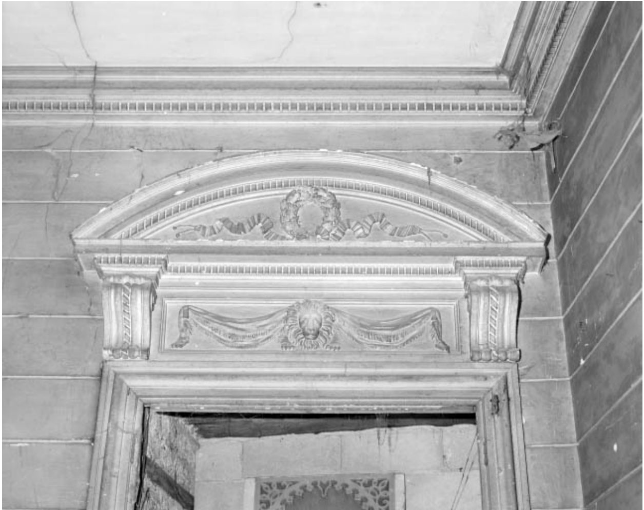
Intérieur : escalier d'honneur, porte gauche sur le palier, détail du fronton.
