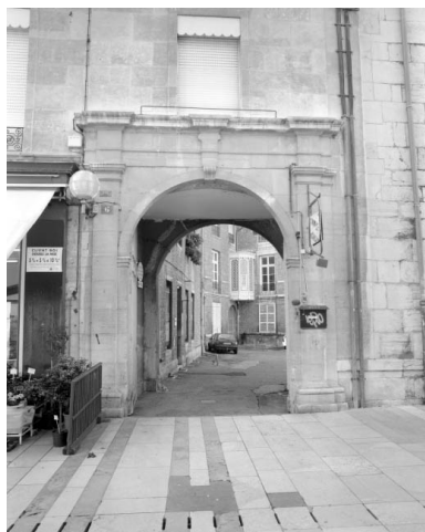
Façade sur rue : détail de l'entrée cochère. Phot. Yves Sancey IVR43_20012500235X
