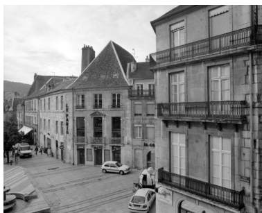
Façade sur rue, de trois quarts droit. Phot. Yves Sancey IVR43_20012500210X
