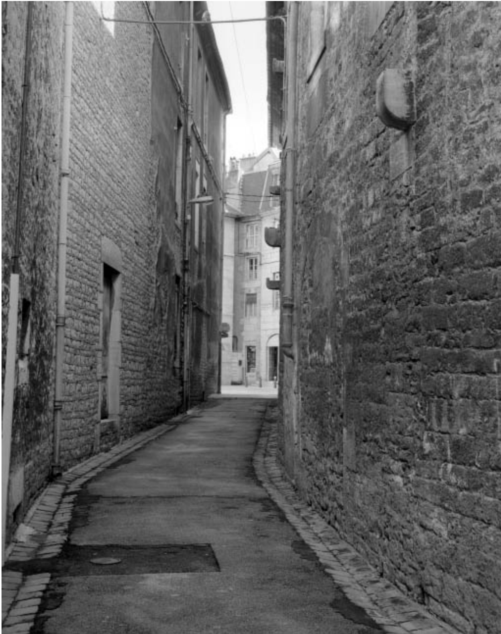
Façade latérale gauche donnant sur la rue du Loup.
