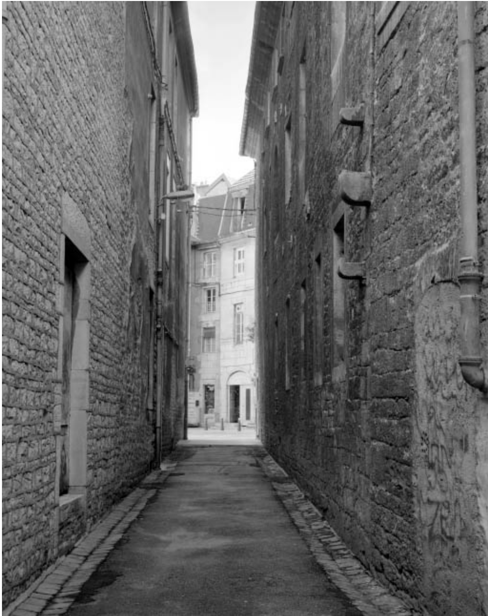
Façade latérale gauche : vue rapprochée.
