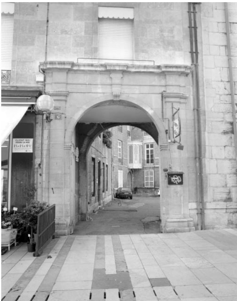
Façade sur rue : détail de l'entrée cochère.
