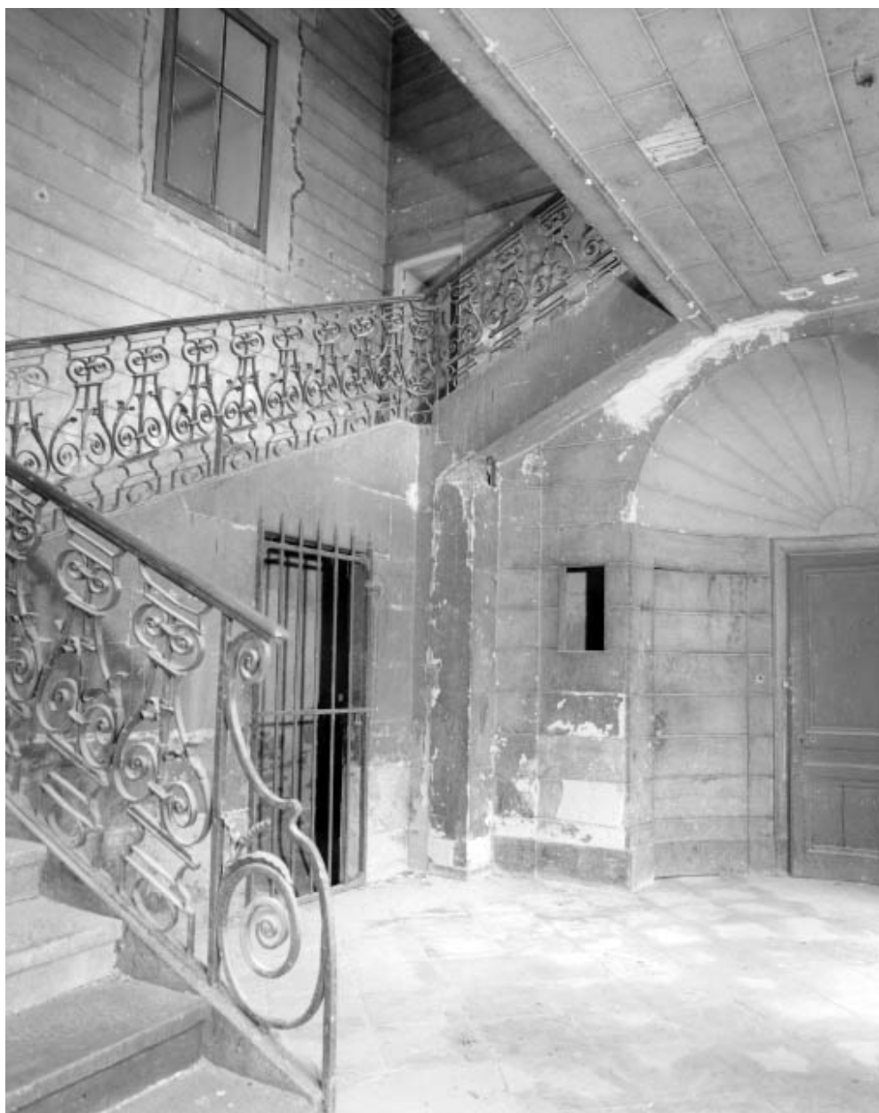
Intérieur : escalier d'honneur, vue d'ensemble en hauteur.
