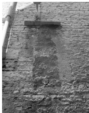
Façade latérale gauche : détail d'une baie murée. Phot. Yves Sancey IVR43_20012500252X
