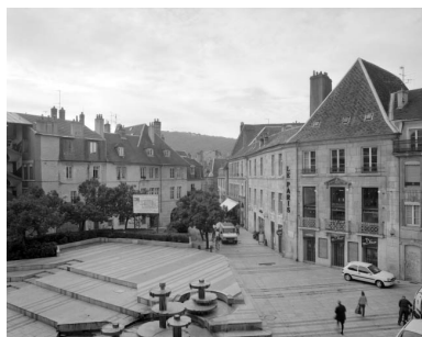
Façade sur rue, de trois quarts droit. Phot. Yves Sancey IVR43_20012500207X
