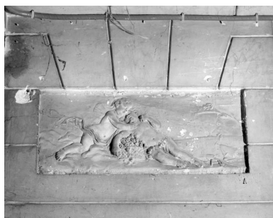
Intérieur : escalier d'honneur, détail d'un décor du rez de chaussée. Phot. Yves Sancey IVR43_20012500234X
