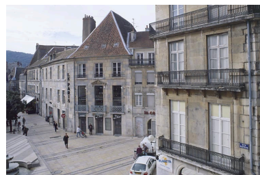
Façade sur rue, de trois quarts droit. Phot. Yves Sancey IVR43_20012500328XA
