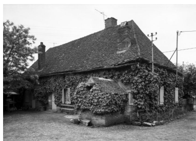
Logis d'une ferme (cad. 1981, sect. B2, parc. 352). Phot. Michel Rosso IVR26_19862100562V
