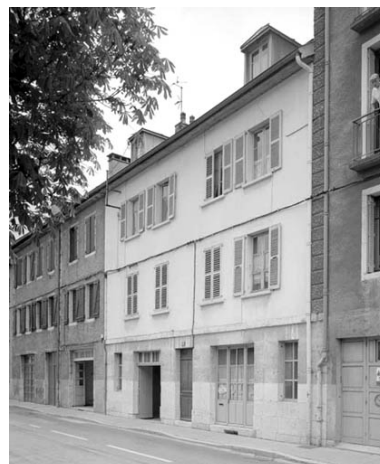
Façade antérieure de l'immeuble. Phot. Jérôme Mongreville IVR43_19923900367X
