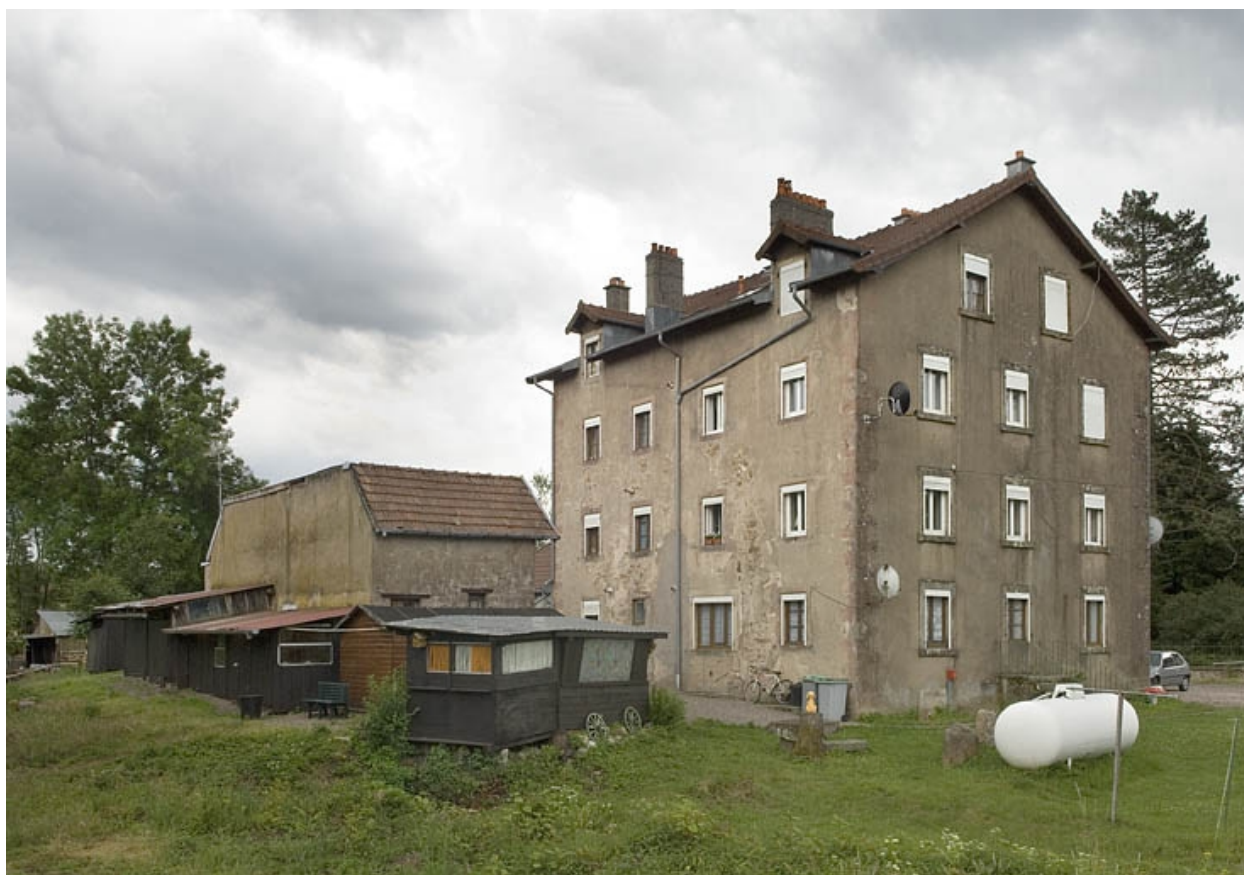
Vue d'ensemble depuis le pont.
