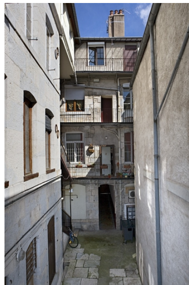
Vue d'ensemble de la façade postérieure du logis principal depuis le fond de la cour. Phot. Yves Sancey IVR43_20082500350NUC2A
