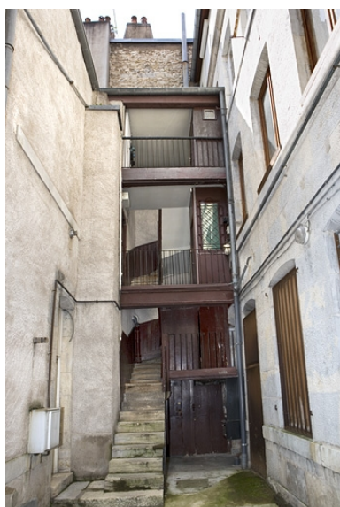
Vue d'ensemble des logis secondaires depuis l'entrée de la cour. Phot. Yves Sancey IVR43_20082500349NUC2A
