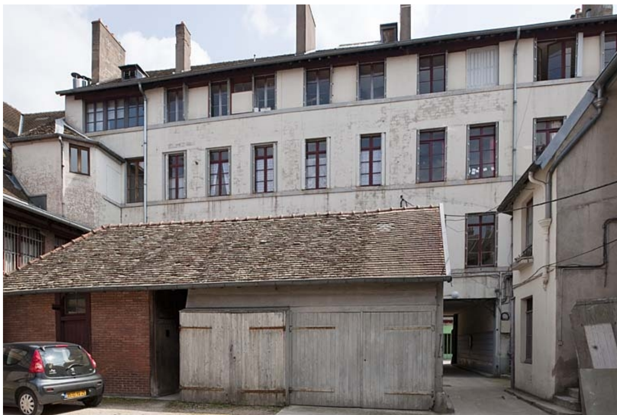
Façade postérieure de l'immeuble depuis la cour.
